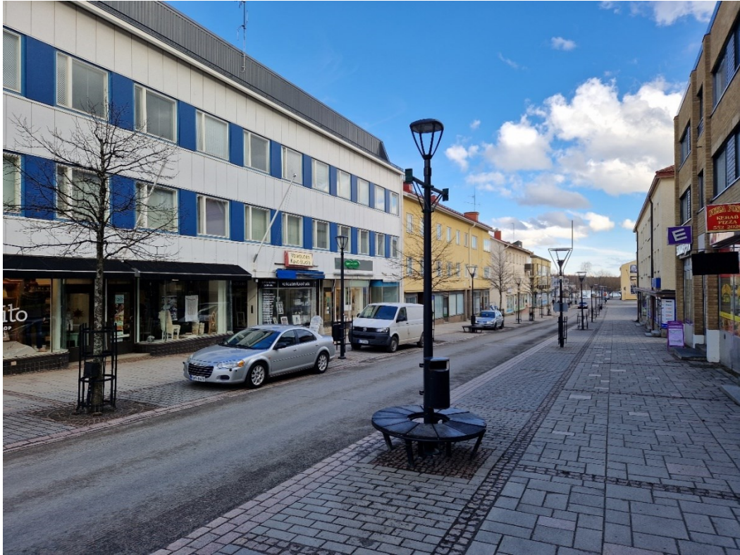
KUVA 12. Yleiskuva Kauppakadulta. Asennettuna kaksi Story -valaisinta (Pirskanen, 2023)
