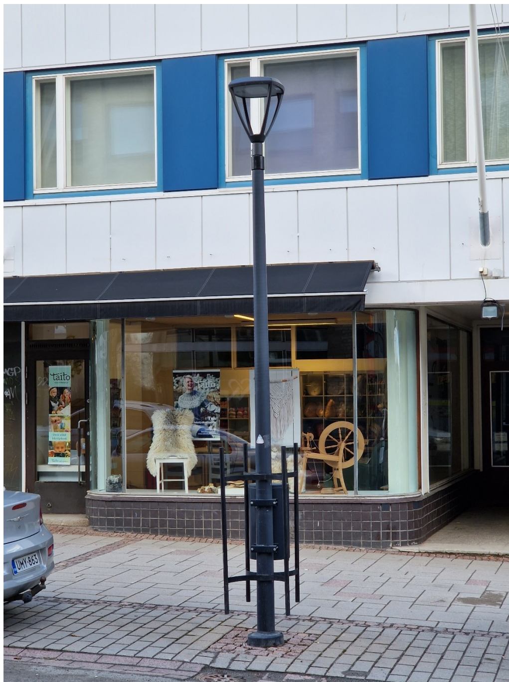
KUVA 11. AEC Story -valaisin asennettuna Kauppakadulle (Pirkanen, 2023)
