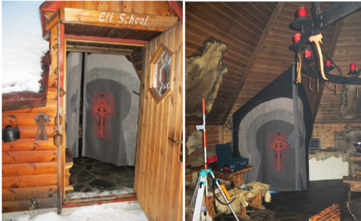
Kuvat 3 ja 4. Ovisuoja villahuovasta, kuvattuna ulkoa ja sisältä (Kuvat: Reeta Sipola)
