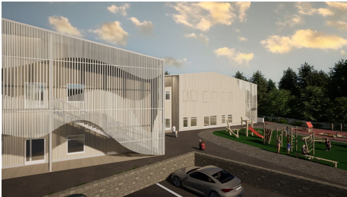
KUVA 23. Päiväkodin länsipuolen sisäänkäynnin rimoitus (Lodi 4/2023)
