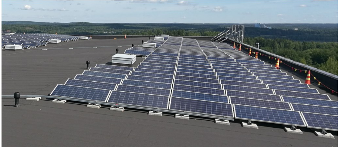
Kuva 10: Bitumikatolle tehty kelluva painoperustainen aurinkopaneelien asennus FS-M -asennusjärjestelmällä (Finnwind Oy 2023).
