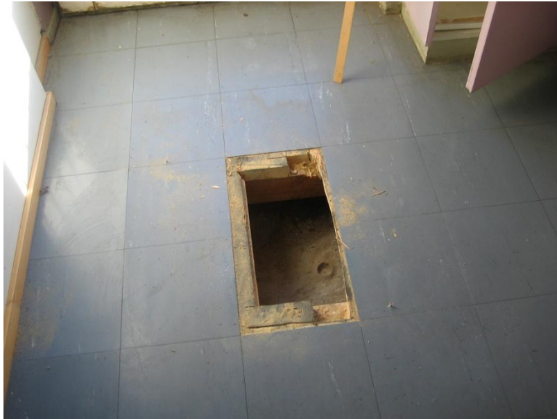
Kuva 13. Tutkimusaukko A-kellarin lattiassa.
