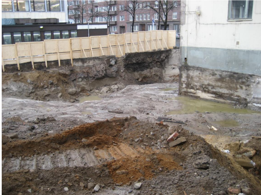
Kuva 7. Kuva idästä päin työmaalta, kun maa-aines oli kaivettu.
