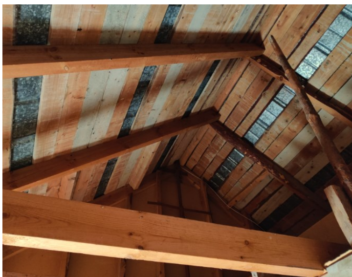
KUVA 7. Vesikattorakenne eroaa nykypäiväisestä asuinrakennuksen rakenteesta.
