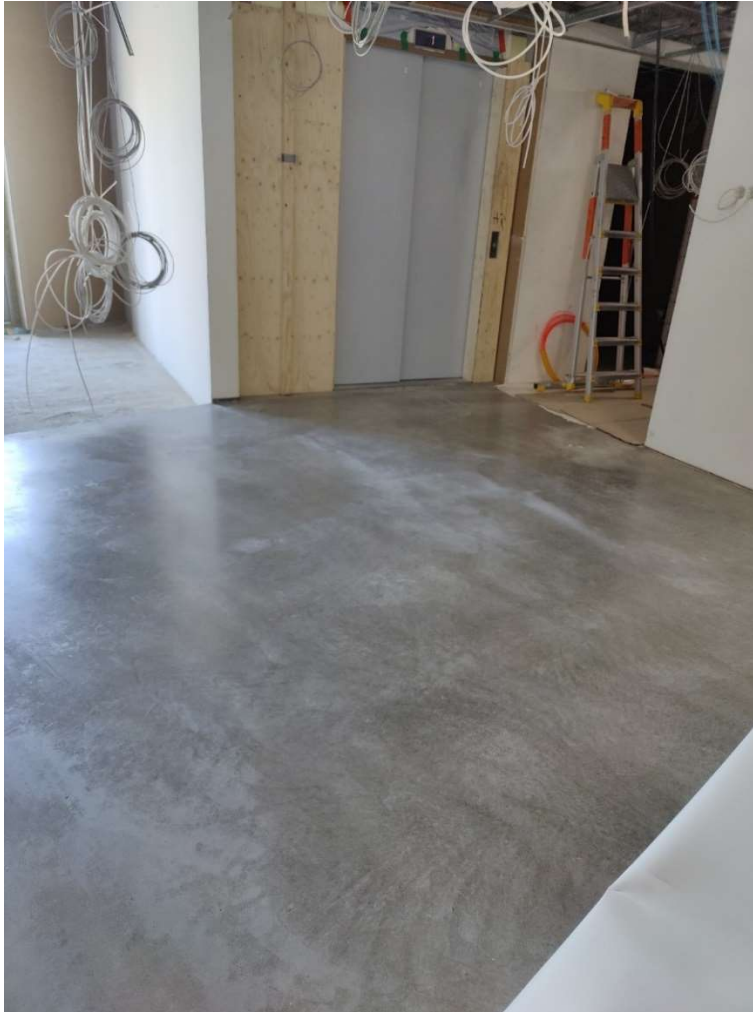
Kuva 8. Designbetonilattia Karin Kampuksella.
