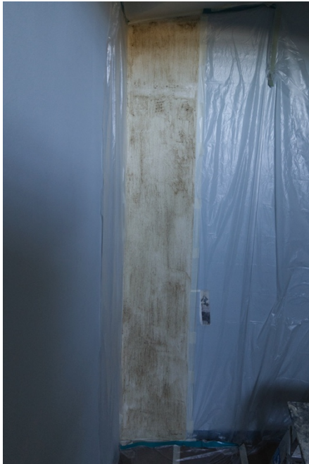
Kuva 15 Vernissakyllästetty ja hiekkapinoitettu makulatuuripaperi kohteen eteläseinässä (Paula Isakoff)
