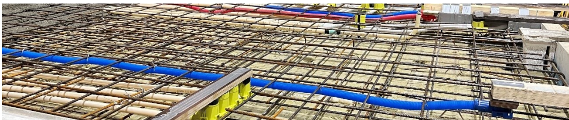
Kuva 7. Sisäkuoren raudoitusta varusteluineen
