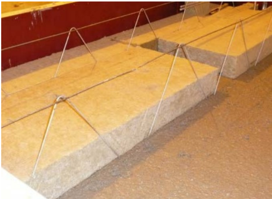
Kuva 6. Diagonaaliensaiden asennus (Peikko Finland Oy, 2023).
