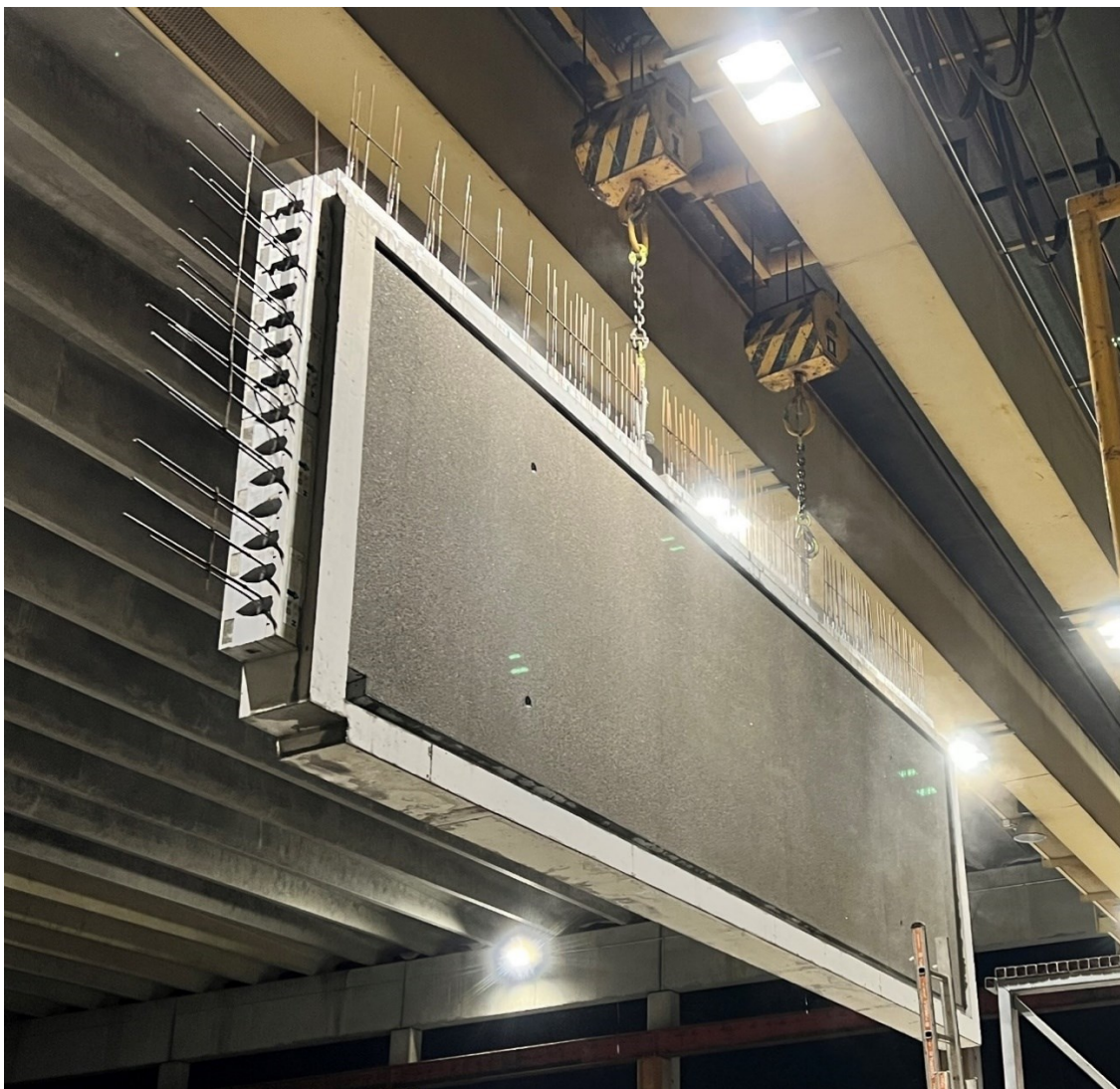
Kuva 8. Valmis ulokeparvekelaatta menossa varastoon.
