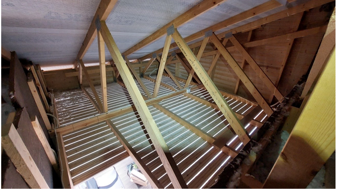
Kuva 4. Yläpohjarakenteita pääsisäänkäynnin kohdalla.
