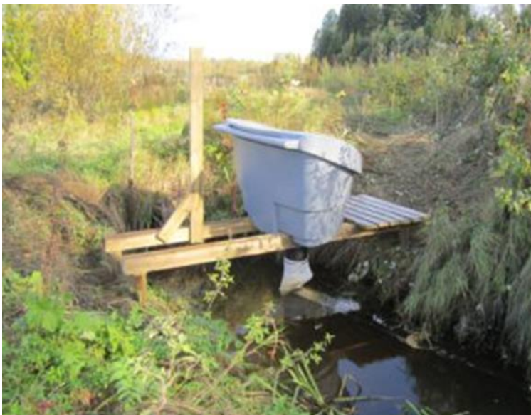
Kuva 17. Itserakennettu fosforisuodatin Loppijärvellä (Loppijärven ystävät ry, n.d.)
