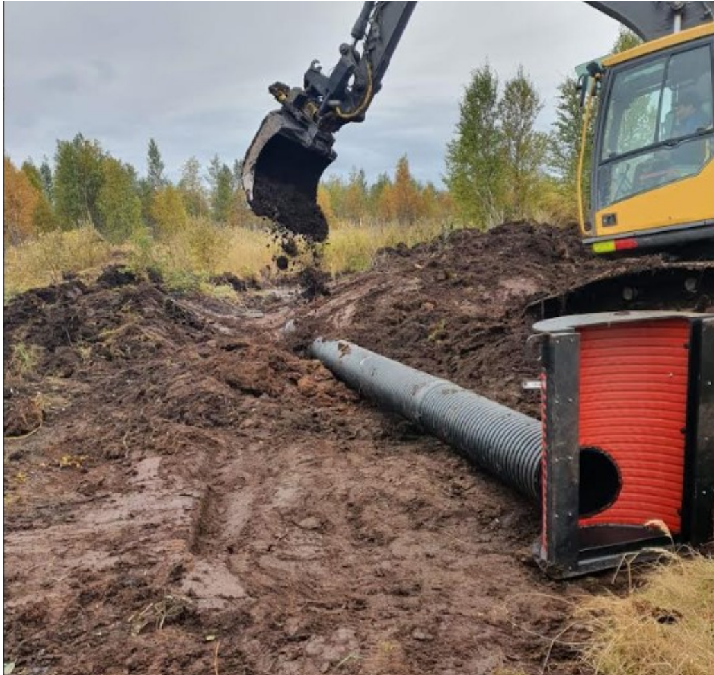
Kuvio 11. Puolimunkin asennustyö Siperian kosteikolla 2021. (Kuva: Markku Viereä)
