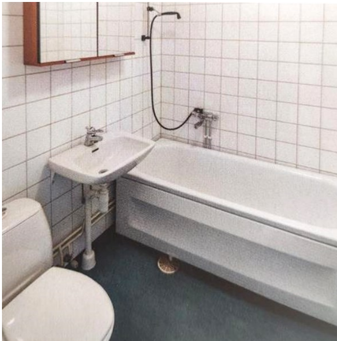
Kuva 8. 1960-luvun kylpyhuone, jossa kylpyamme ja lattiassa muovimatto toimivat vedeneristeenä (Björk ym. 2020, 201).
