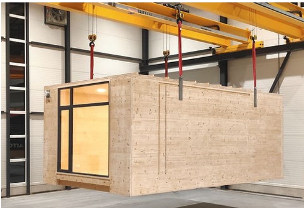
Kuva 7. Kokonainen CLT-moduuli nosturin varassa. (Aitopuu Suomi Oy)
