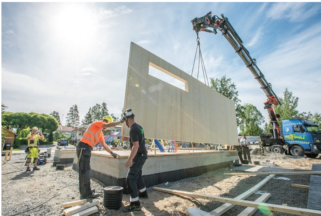
Kuva 6. CLT-seinäelementin paikalleen asennus. (Hoisko 2020)
