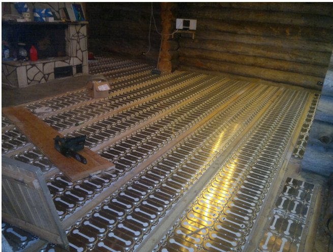
Kuvio 14. DEVIcell-asennuslevyt kipsilevyjen päällä.
