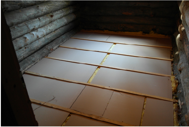
Kuvio 13. Kipsilevyt eristeen päällä.
