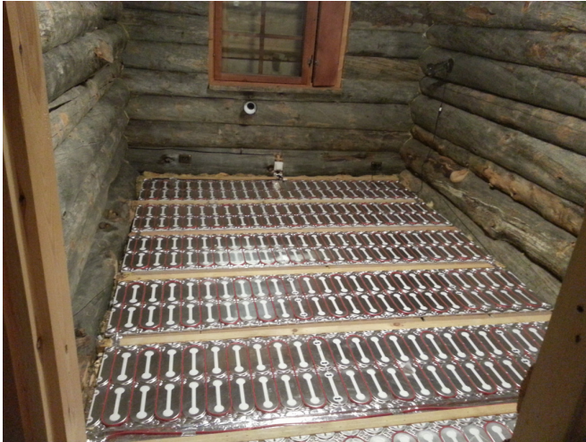
Kuvio 15. DEViflex kaapeli kiinnitetty asennuslevyihin.
