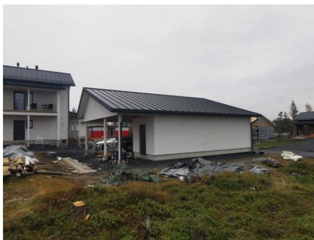
Figur 1. Bild över Garagets sida mot söder.
