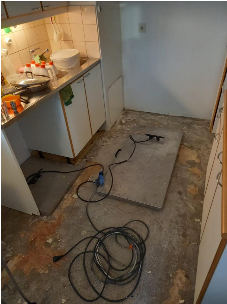
Kuva 4. Kuvassa infratasokuivaimet asennettuna vaurioalueelle
