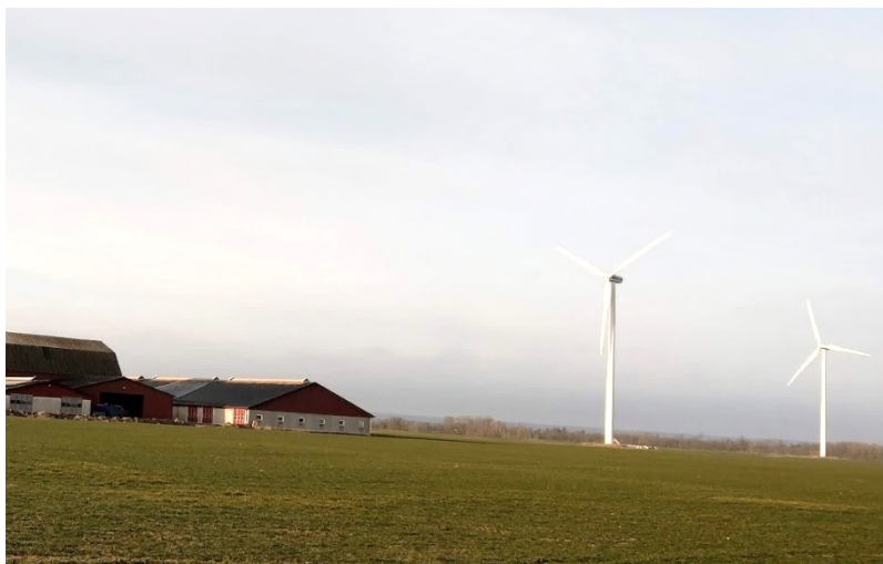
KUVA 5. Vaaka-akselisia tuulivoimaloita maatilalla Ruotsissa (Tuovinen 2019)
