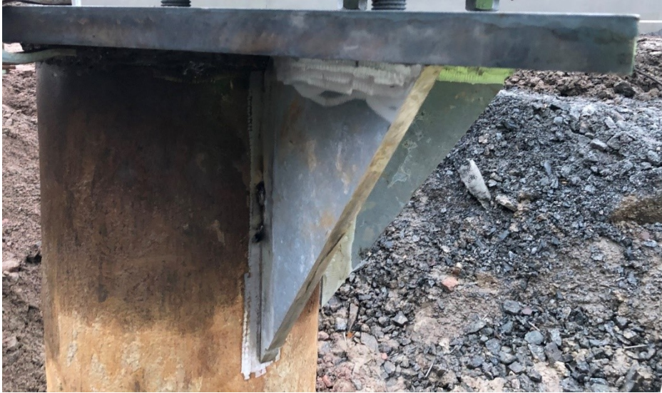
Kuva 17. Paalun uusi ylälevy ja kulmatuennat.
