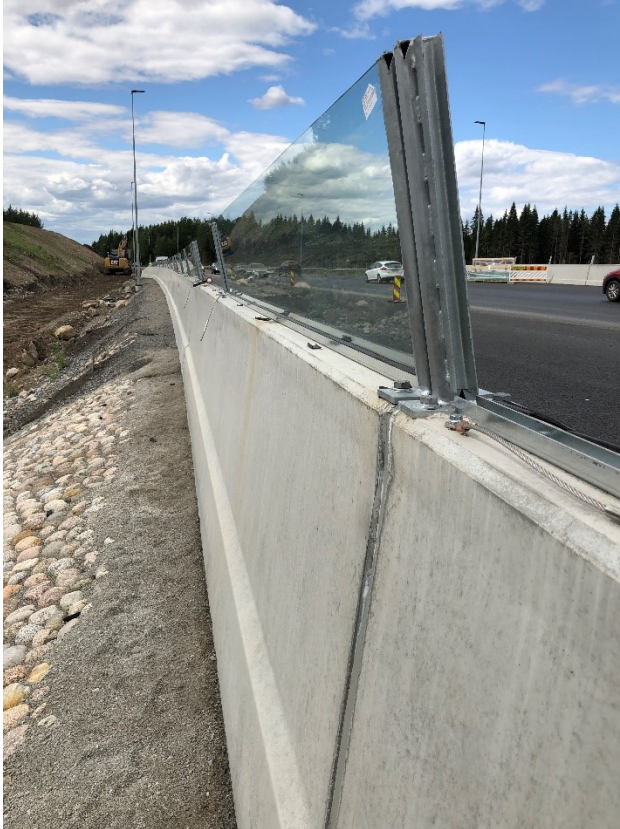
Kuva 2. Melukaide läpinäkyvällä korotusosalla Lamminrahkassa.
