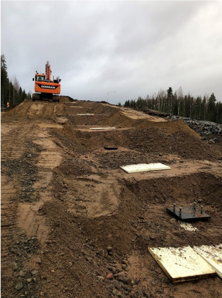
Kuva 18. Finnfoam 50 mm eristelevyt asennettuna.
