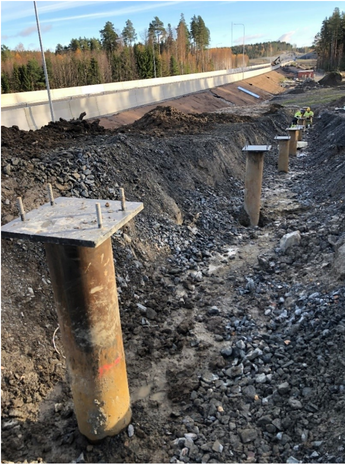
Kuva 15. Paalujen kaivannot ja ylälevyjen asennusta.
