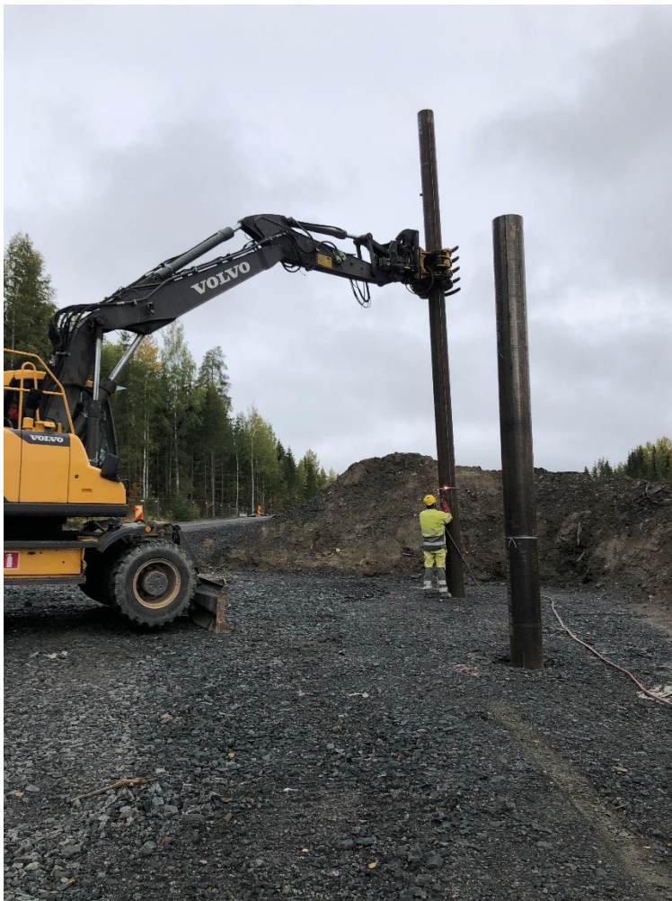
Kuva 12. Pitkien paalujen katkaisua.
