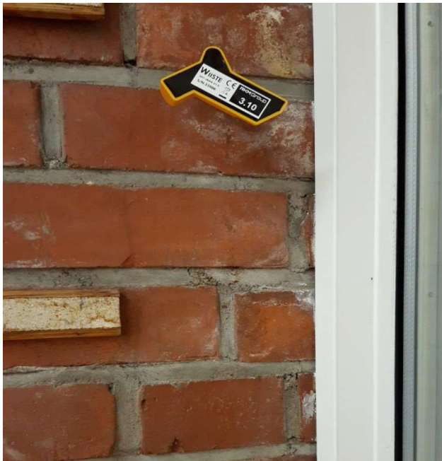
Kuva 16. Etäluettava anturi asennettuna tiiliseinässä
