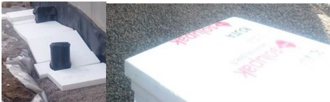
Kuva 3. EPS-eristeen asennusta työmaalla (Aimo Kekäle 2023).
