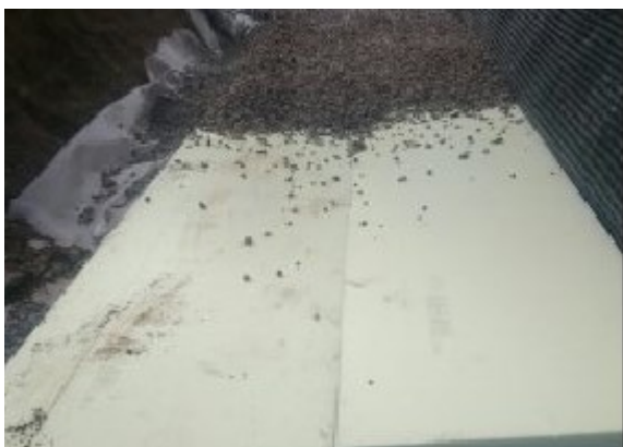
Kuva 2. XPS-eristettä asennetaan liikennöidylle alueelle (Aimo Kekäle 2023).
