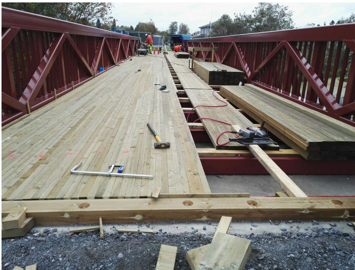
Figur 2. Bro med ytlager av 150x50 mm impregnerade plankor (Kim Sydholm 2018)
