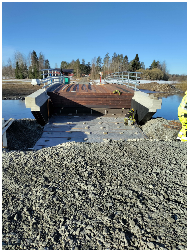
Figur 1. Balkbron som monterats. (Kim Sydholm, 2022)
