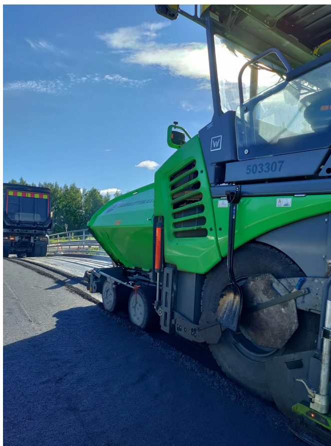
Figur 8. Asfaltläggare applicerar ytlager med ab16. (Kim Sydholm 2022)
