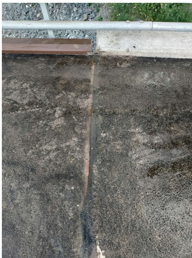
Figur 11. Rörelsefog fyllt med bitumenmassa. (Kim Sydholm 2022)
