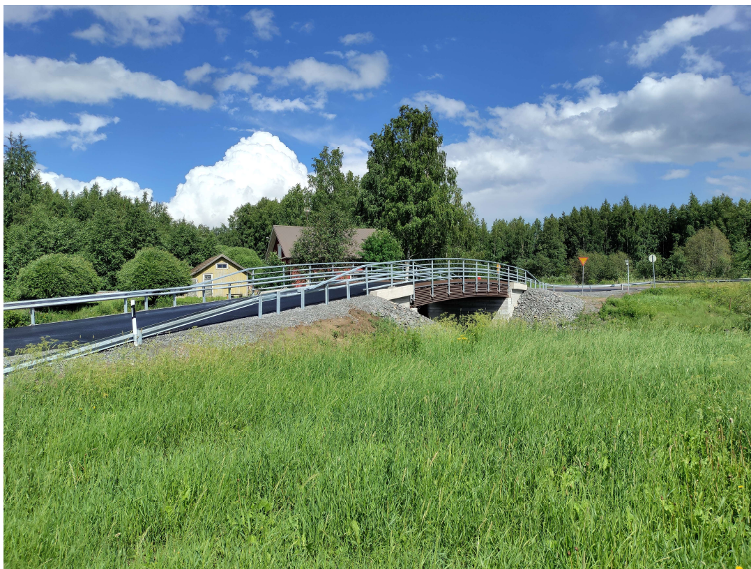
Figur 13. Färdigställt broprojekt som överlåtits. (Kim Sydholm 2022)
