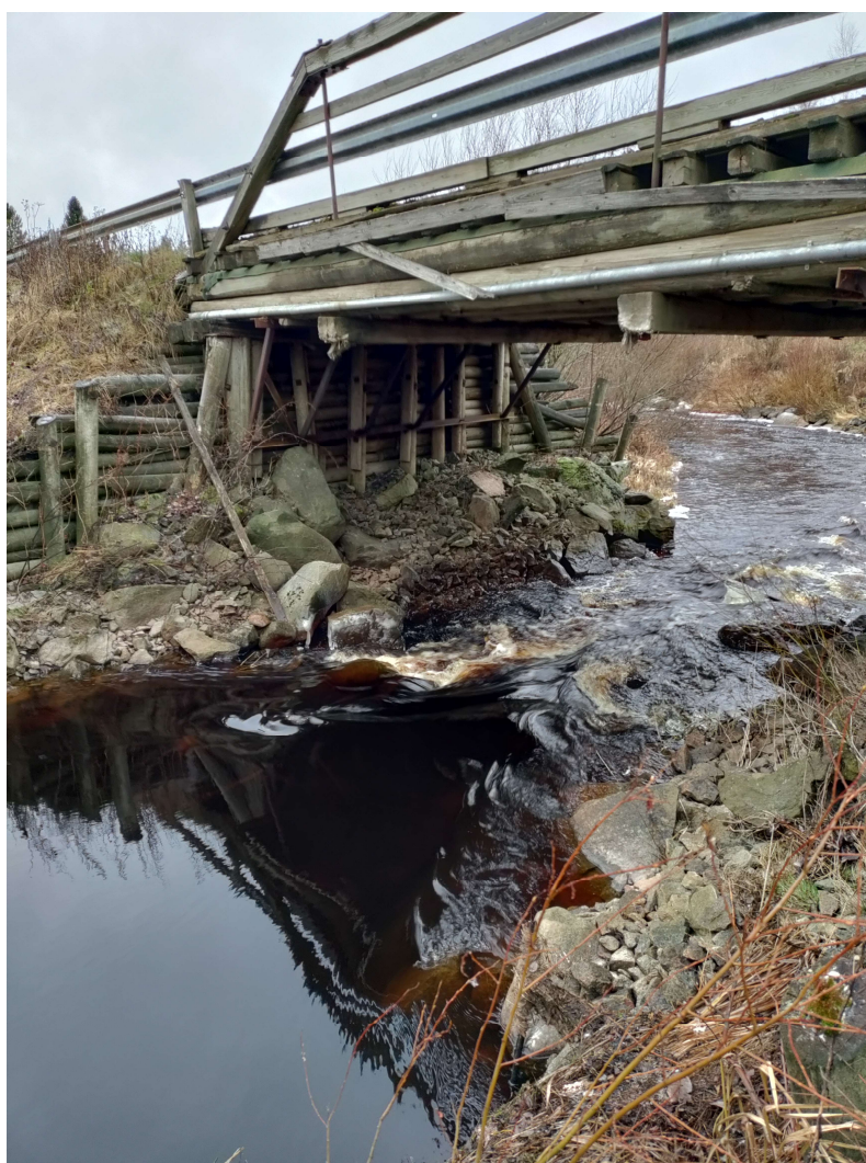
Figur 6. Den gamla brokonstruktionen. (Kim Sydholm 2022)
