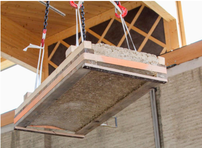
Kuva 47 Erdenin suunnittelema massiivisavi-puu-yhdistelmälaatta (soil slab). (Erden.at)
