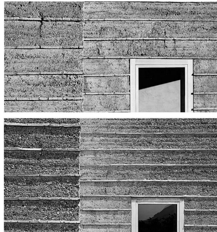
Kuva 7 Talo Rauch ylempänä valmistuttuaan ja alempana kaksi vuotta valmistumisen jälkeen. (Sauer, M. & Kapfinger, O.)
