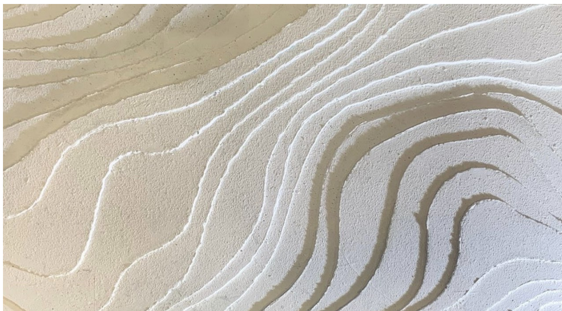
KUVA 22. Muotobetonipintainen mallielementti. (F. Piuva 2021.)
