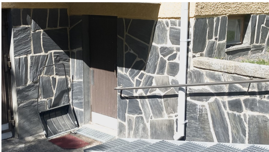
KUVA 1. Vapaamuotoinen luonnonkivilaattaverhoilu 1950-luvun kerrostalon sisäänkäynnin yhteydessä ja sokkeliverhouksessa. (Keinänen 2023.)
