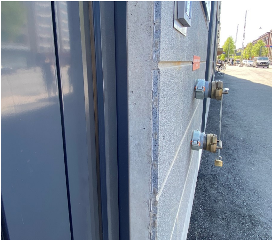
KUVA 42. Oviaukon betonipieli. (Keinänen 2023.)
