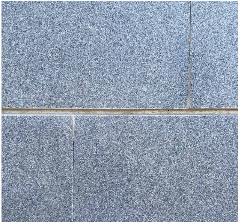
KUVA 36. Lähikuva puskusaumasta. (Keinänen 2023.)
