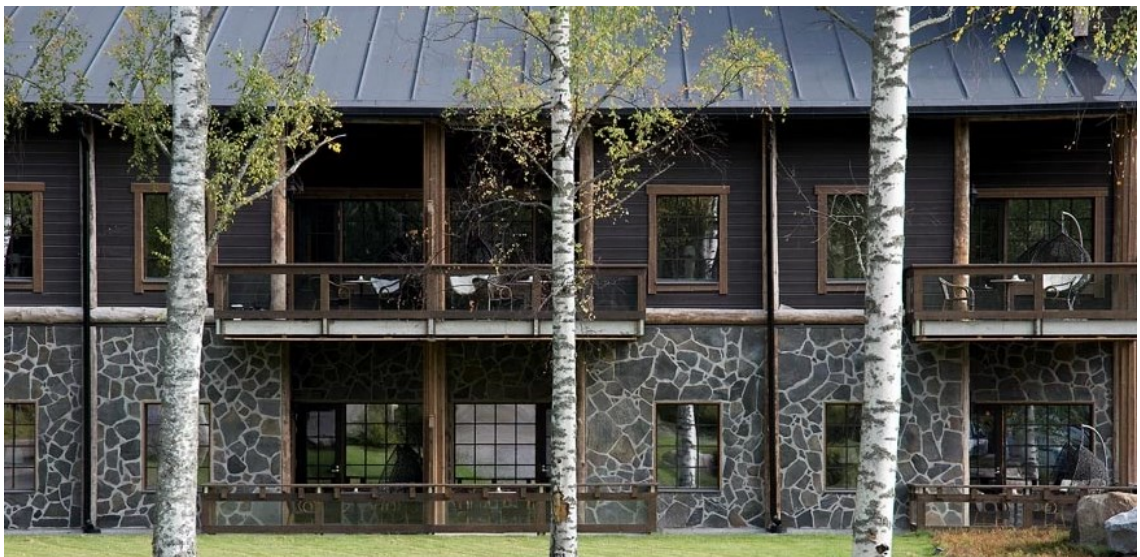
KUVA 39. Elementtien pysty- ja vaakasaumat on kätkeyty puulistojen taakse. (Stonegroup Finland Oy 2023.)
