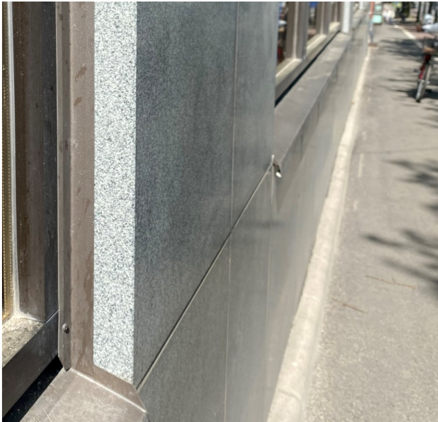
KUVA 40. Luonnonkivilaatoilla verhoiltu ikkunanpieli. (Keinänen 2023.)
