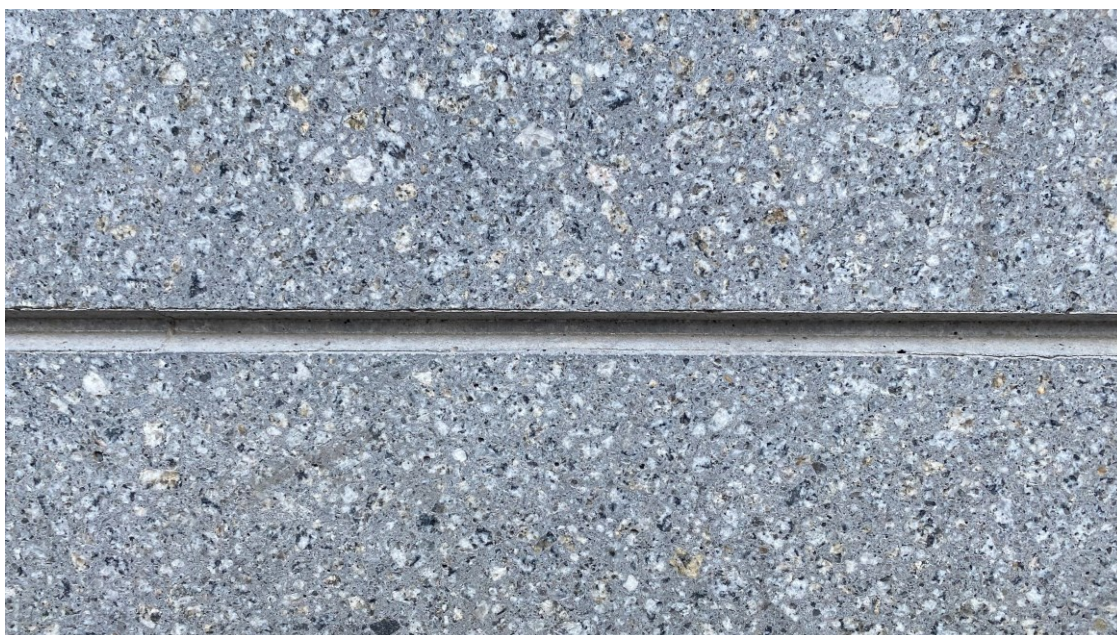
KUVA 21. Mosaiikkibetonipintainen sokkelielementti. (Keinänen 2023.)
