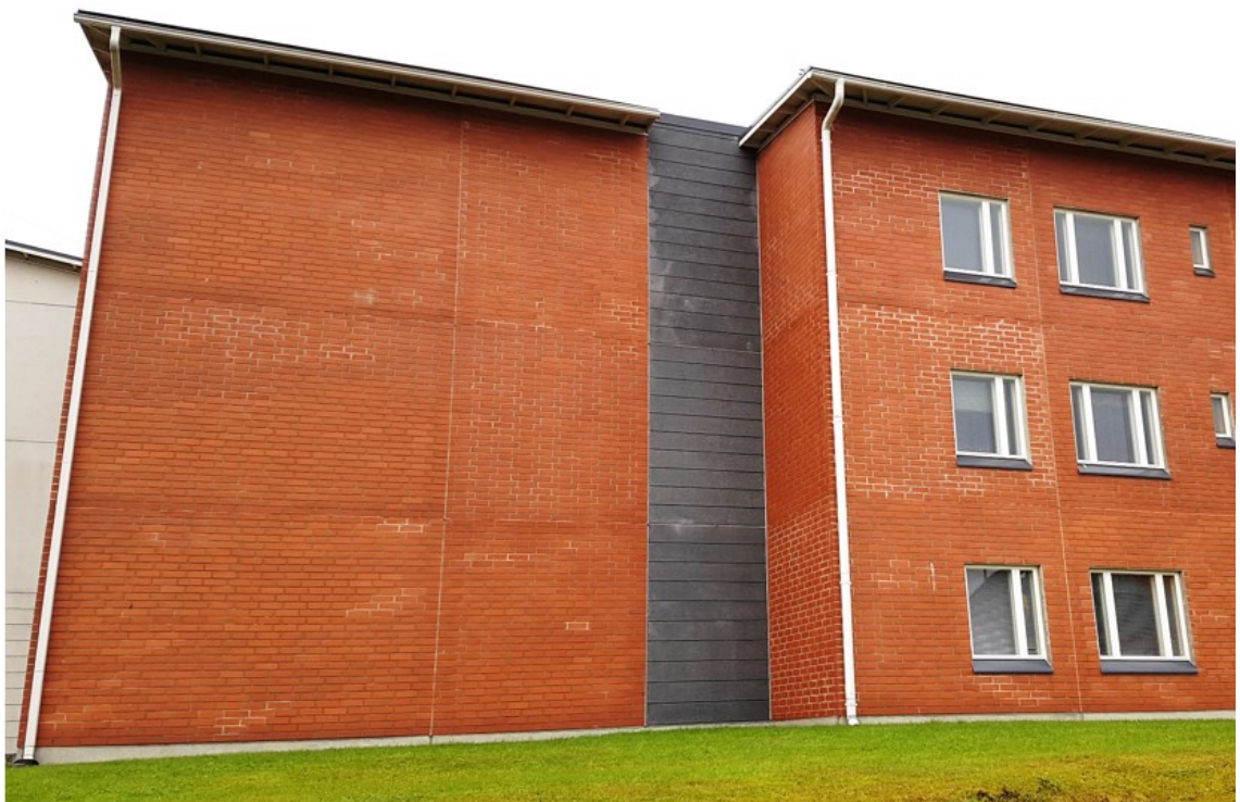
KUVA 16. Tiililaattapintainen julkisivu. (E. Ritola 2019.)
