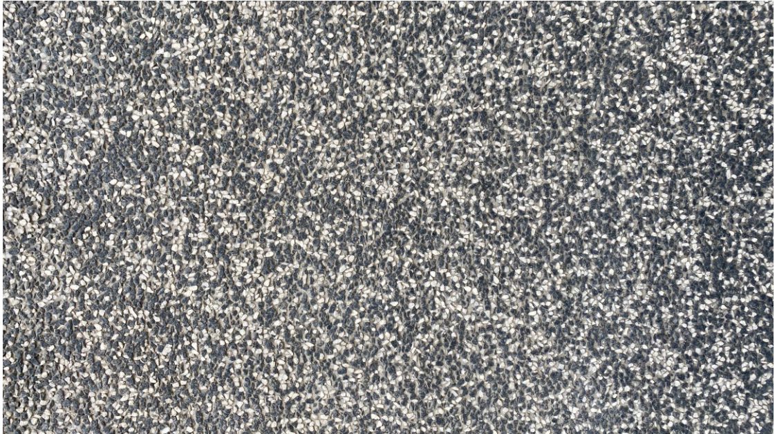
KUVA 18. Pesubetoninen pintakäsittely. (Keinänen 2023.)
