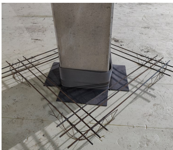
Figur: 13 Ringarmering för pelare (Kenneth Asplund)
