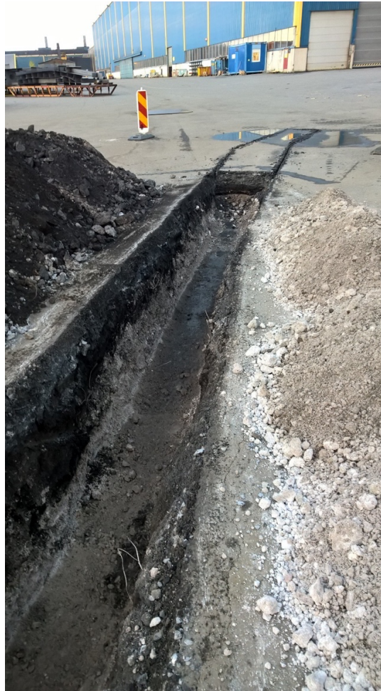
Kuva 1. Putkikaivanto, jossa pilaantunutta maata (Meyer Turku, 2016.)
