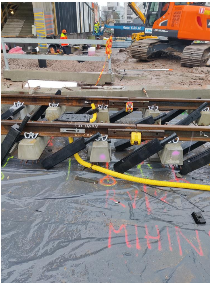
KUVA 2. Sidekiskokiinnitys ja kammiokumeja (2022)
