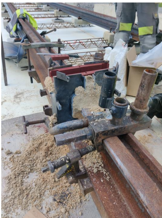
KUVA 6. Topattu termiittimuotti ennen hitsausta (2023)
