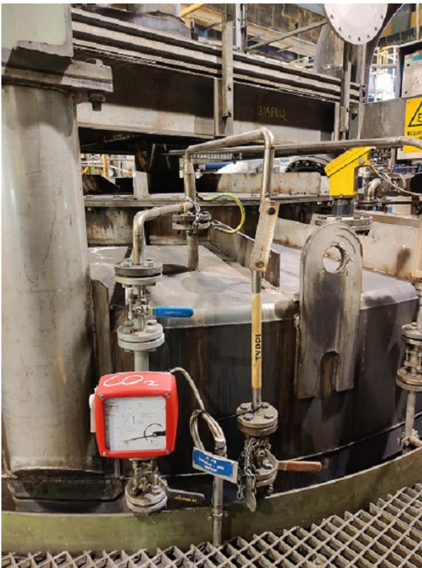
KUVA 3. Puskutankin kanteen menevät typpi ja hiilidioksidi. (Karttunen 2023)
