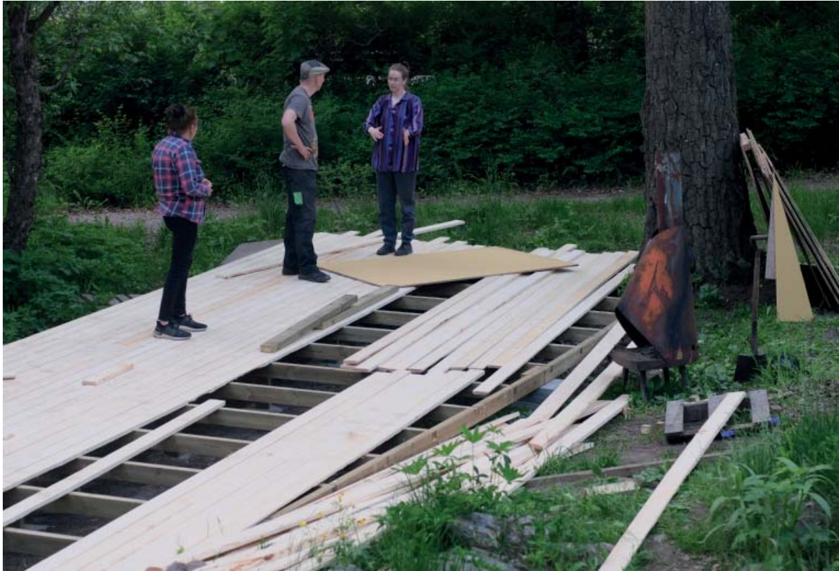
Kuva 12. Tilannekuva lavan rakennusvaiheesta (Rantanen 2022a).
