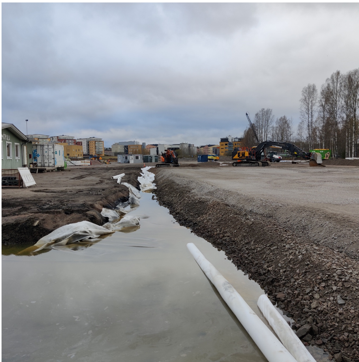
Kuva 2. Kokkonniemen laskettelukeskuksen pysäköintialueen rakenteen parantaminen
