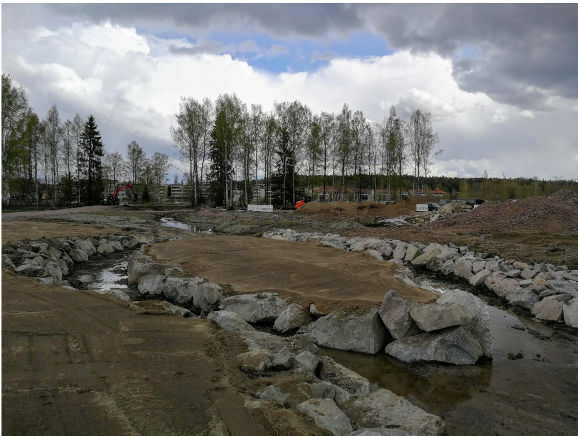
Kuva 1. Tapahtumapuiston hulevesiuoman rakentaminen 2020
