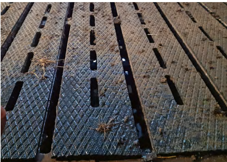
Kuva 3. Karsinoiden betonipalkkilattia on syytä päällystää reiällisellä kumimatolla. Kuva Leena Tuomisto.
