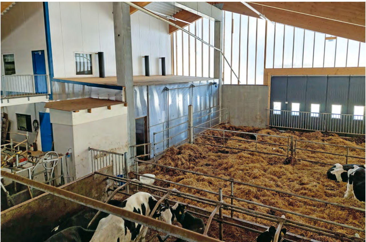
Kuva 2. Tällä esimerkkitalalla poikimakarsinoiden vieressä oleva pikkuvasikoiden tila on erotettu kennolevyillä muun navetan ilmatilasta. Korvausilma tulee vasikoiden tilaan ulkoa ja poisto on navetan ilmatilaan. Vasikat siirtyivät noin 10 päivän ikäisinä vanhaan pihattoon remontoituihin vasikkatiloihin. Kuva Fia Ritvanen.
