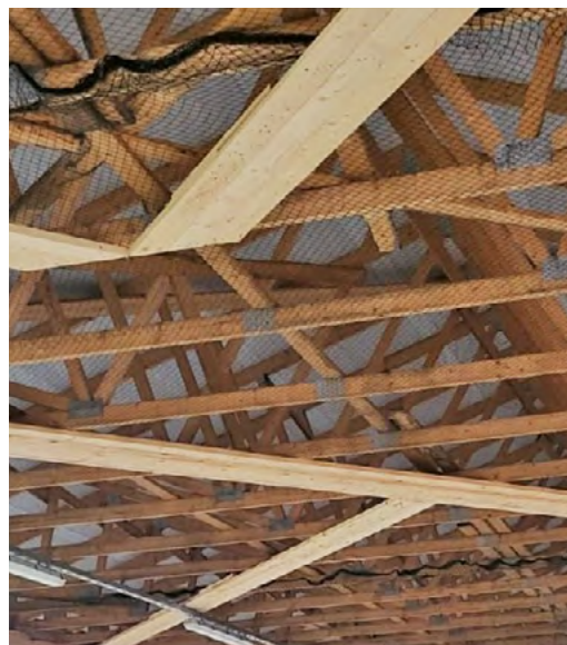
Kuva 27. Esimerkki kattotuoliraenteisesta yläpohjasta, jonka alapohjaan asennetaan lintuverkko. Kuvat NHK-Keskus.
