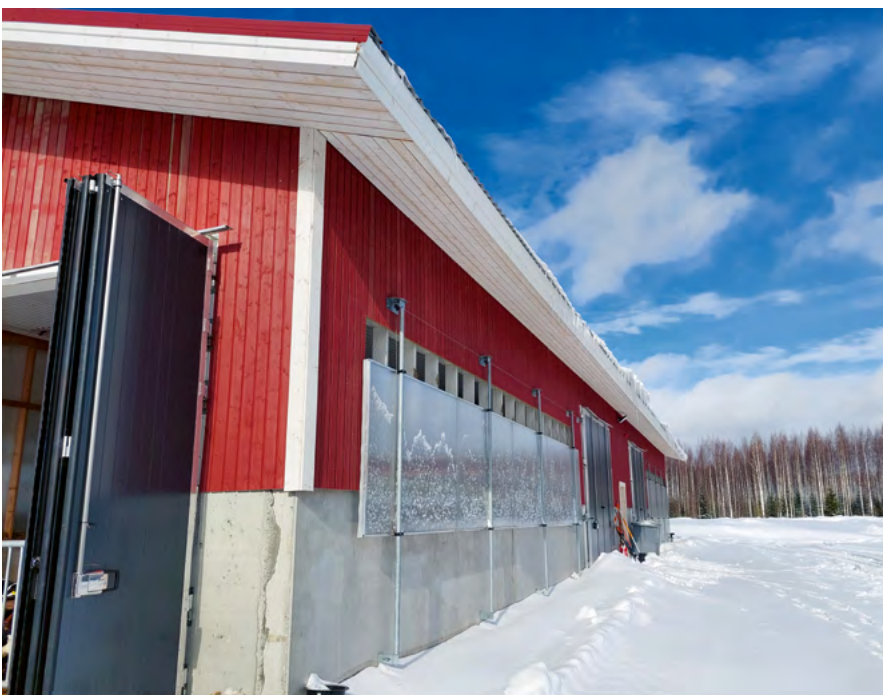
Kuva 29. Vasikkalan ikkunoissa on säädettävät kennolevyt. Tarvittaessa ilman vaihtumista voidaan tehostaa avaamalla karsinan päädyn ovet. Kuva Fiia Ritvanen.
