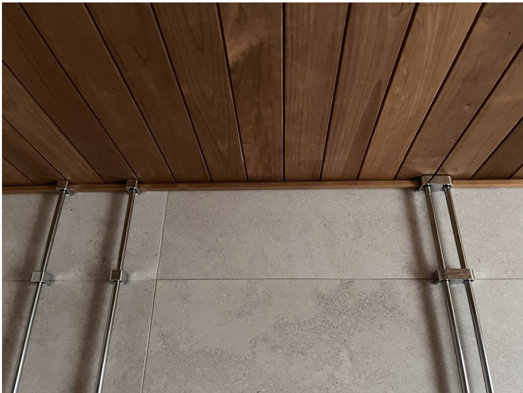
Kuva 16. Läpivienneille jätetään laajenemisvara
