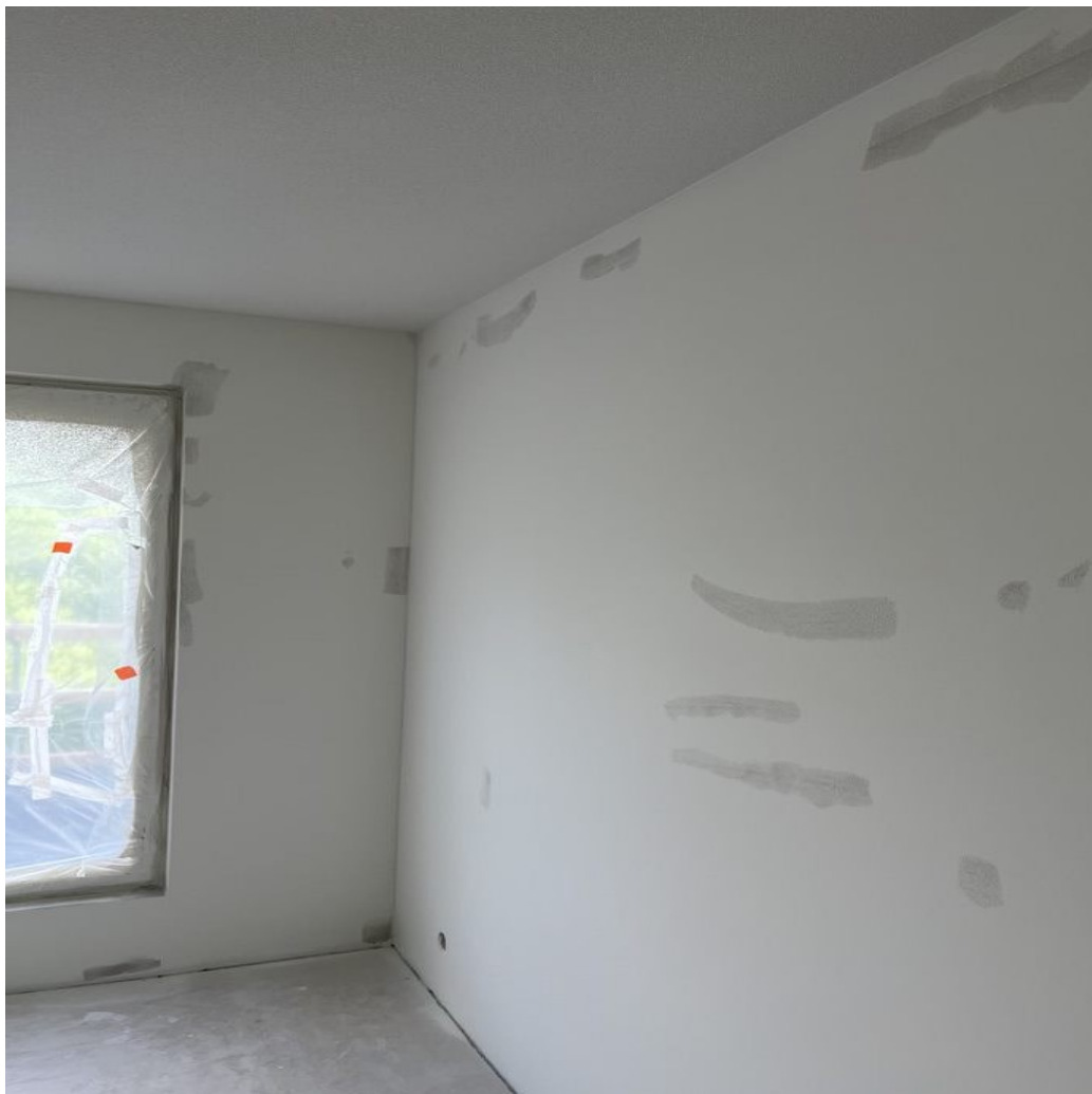
Kuva 9. Kipsipaikkauksia pohjamaalikerroksen päälle.
