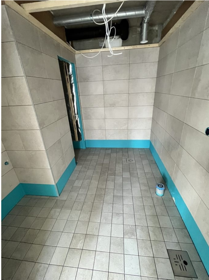
Kuva 14. Seinän alin rivi laatoitetaan viimeisenä
