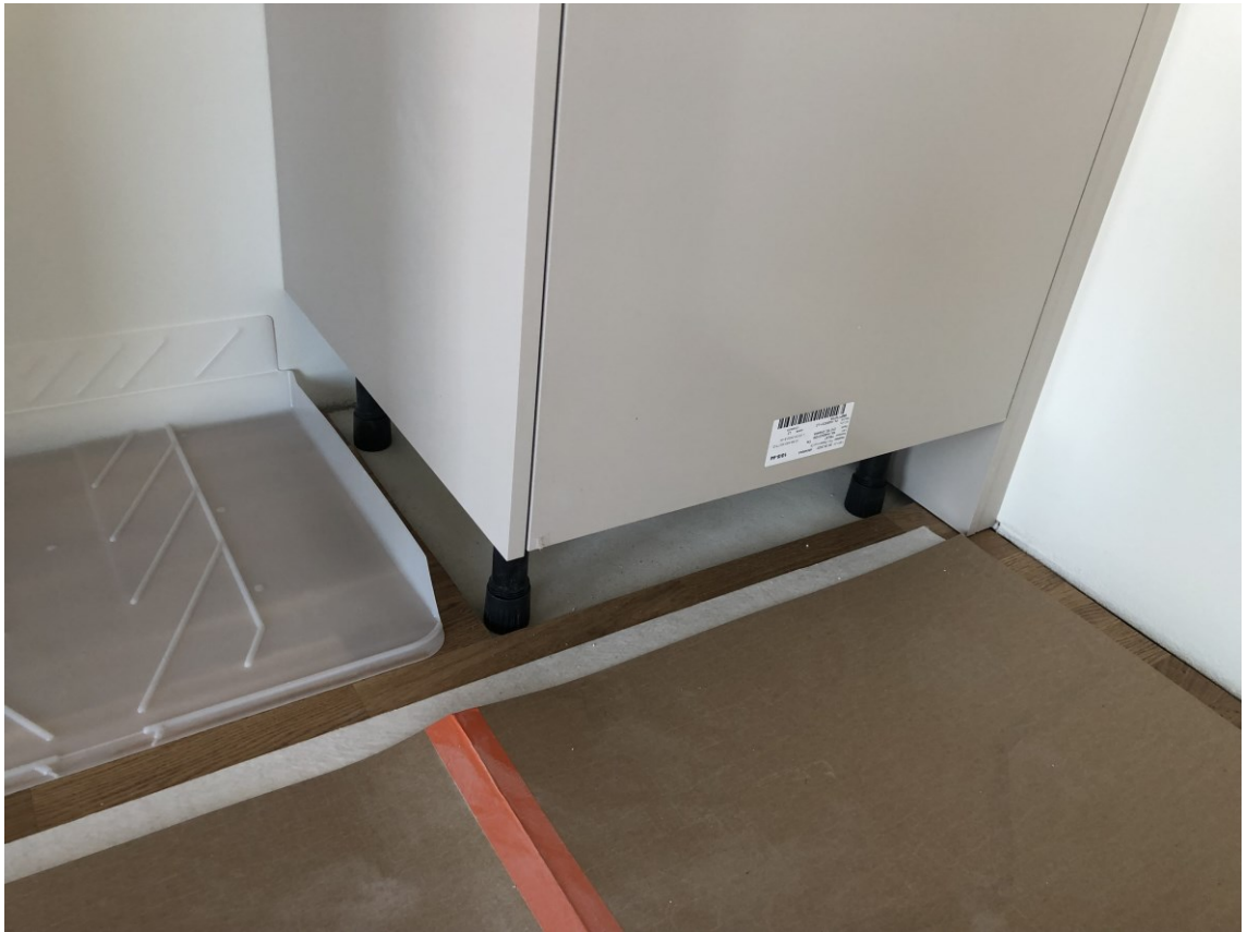
Kuva 19. Parketti asennetaan astianpesukoneen vuotokaukalon alle, muttei kiintokalusteiden alle.
