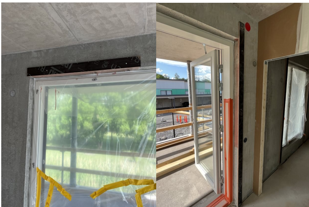
Kuva 7. Smyygien ohjauspuut kipsitäyttöjä varten
