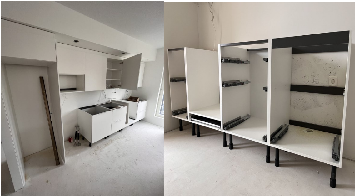
Kuva 18. Keittiön kiintokalusteiden asennus
