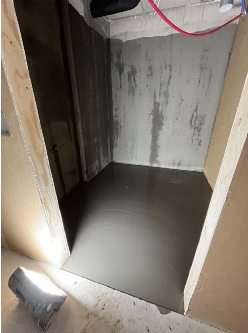
Kuva 11. Pohjatyöhön sisältyy seinien oikaisu ja kaatojen viimeistely
