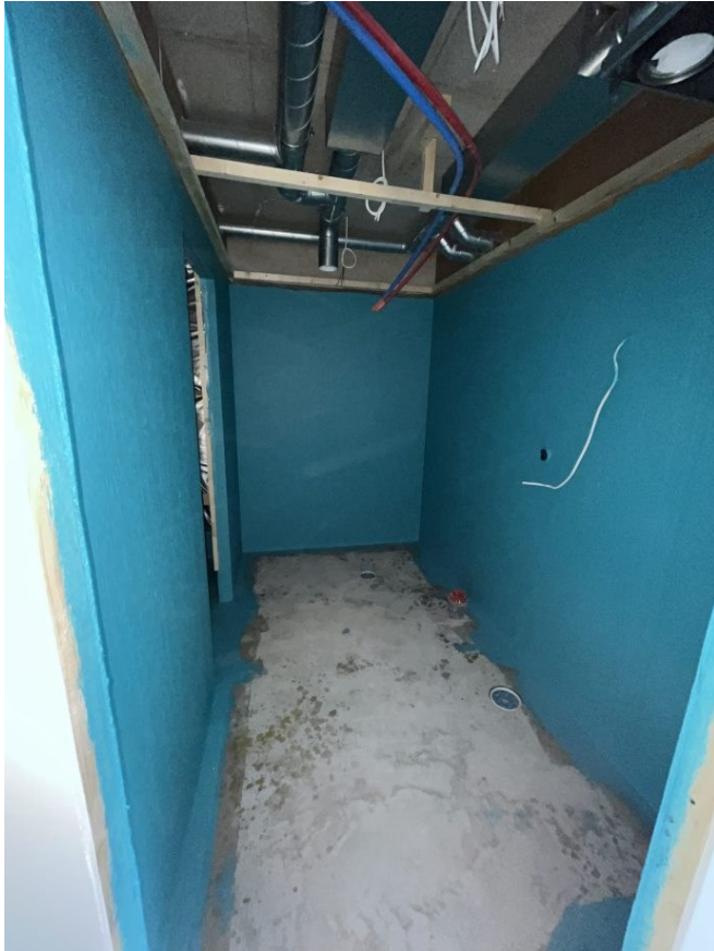
Kuva 12. Märkätilan seinien vedeneristys
