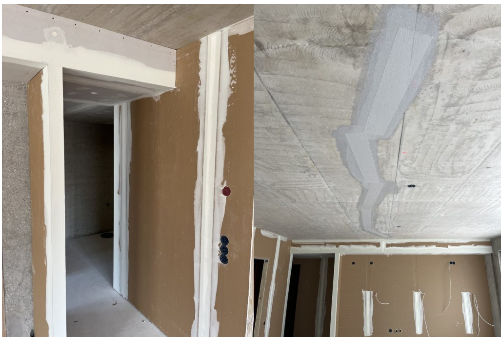
Kuva 8. Saumanauhoitus. Paikallavaluholvin pieniin halkeamiin vesieristenauha
