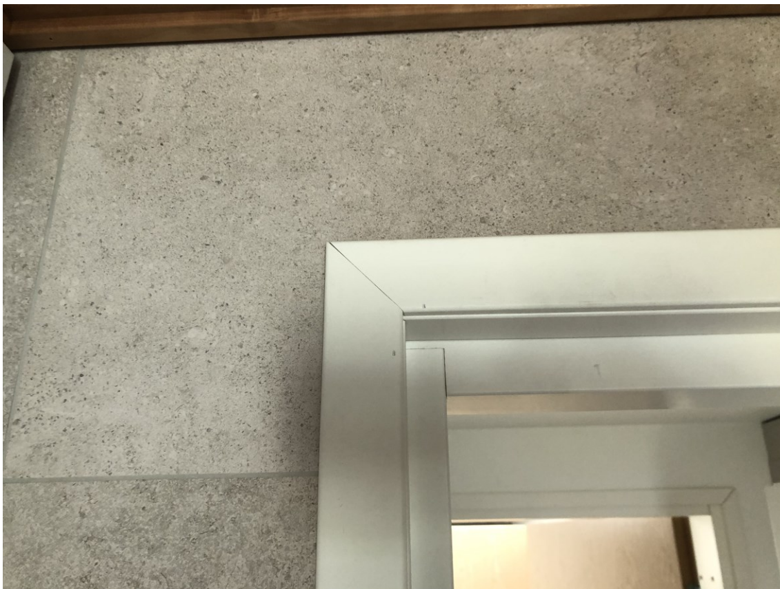
Kuva 20. Kylpyhuoneen ovenkarmin lista asennettiin jiiriin, eli 45° kulmaan.
