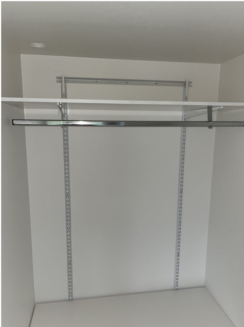
Kuva 17. Vaatehuoneen vaakakiskon taakse on asennettu tukivaneri
