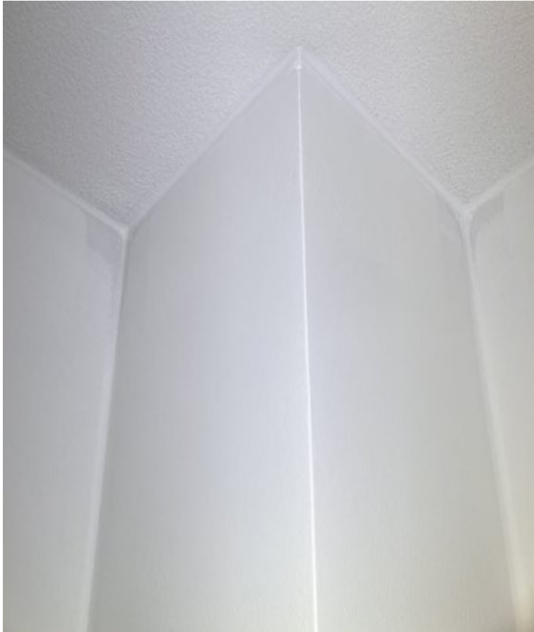
Kuva 10. Katonrajan ja nurkkien kittaus tehdään ennen pintamaalia
