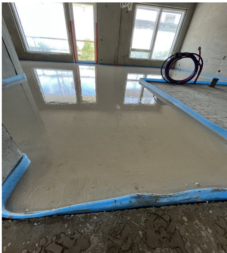
Kuva 4. Tuore kipsilattiavalu sekä irrotuskaista käytävältä kuvattuna
