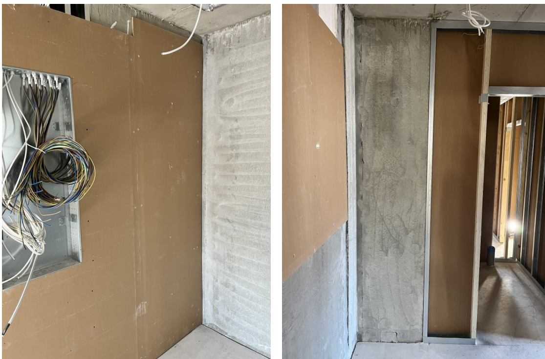
Kuva 5. Väliseinärakennetta jatkettiin betonielementin yli
