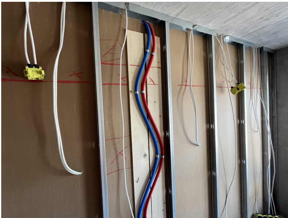
Kuva 6. Keittiökaappien asennustukivanerit
