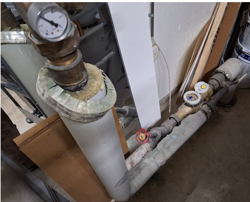
Kuvio 44. Vesiverkoston paineenalennusventtiili ja virtausmittaus.
