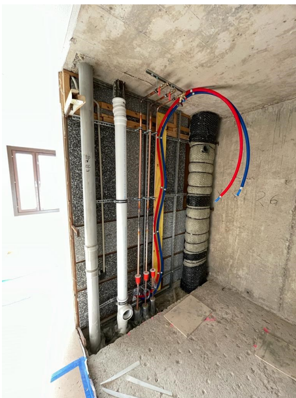
Kuva 8. Havainto vesi- ja viemärlaitteiston nousulinjan kannatuksesta.
