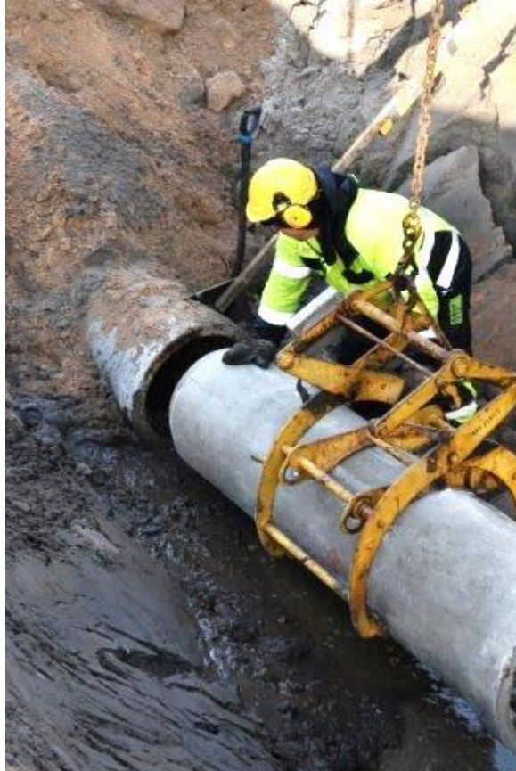
Kuva 14. Betoniputken asennus saksinostimilla (J. Eloranta, henkilökohtainen tiedonanto 11.3.2014).
