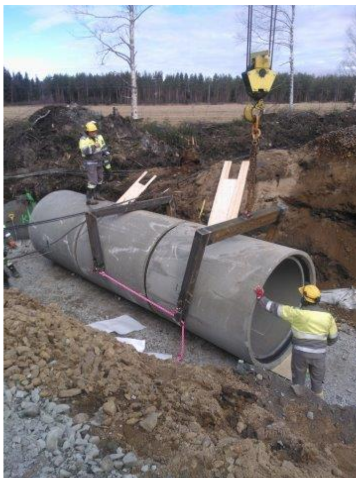
Kuva 15. Betoniputken asennus vetolaitteella (J. Eloranta, henkilökohtainen tiedonanto 11.3.2014).
