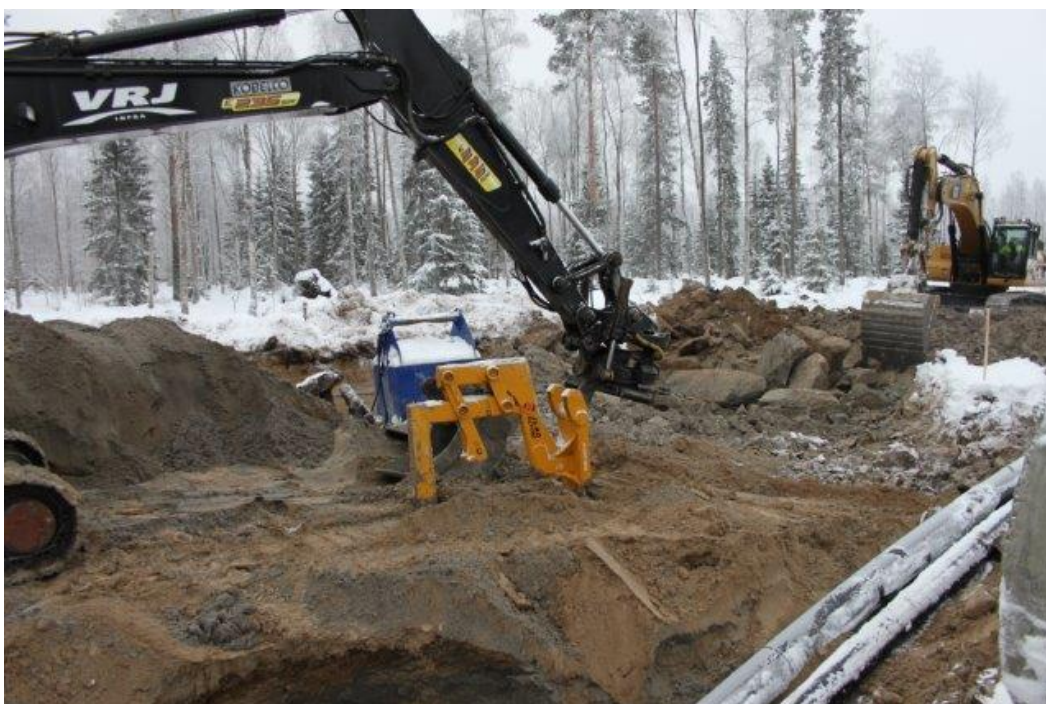
Kuva 16. RB-lifterin kiinnittäytyminen kaivinkoneeseen (J. Eloranta, henkilökohtainen tiedonanto 11.3.2014).
