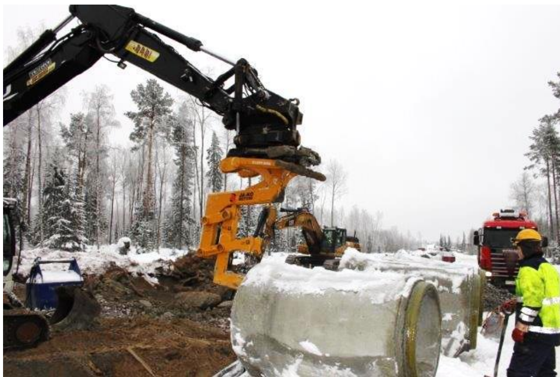
Kuva 19. Putken nosto kaivannon vierestä (J. Eloranta, henkilökohtainen tiedonanto 11.3.2014).
