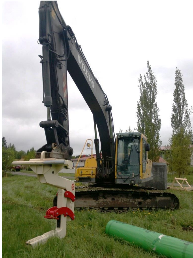
Kuva 17. Kaivinkoneeseen asennettu RB-lifter.
