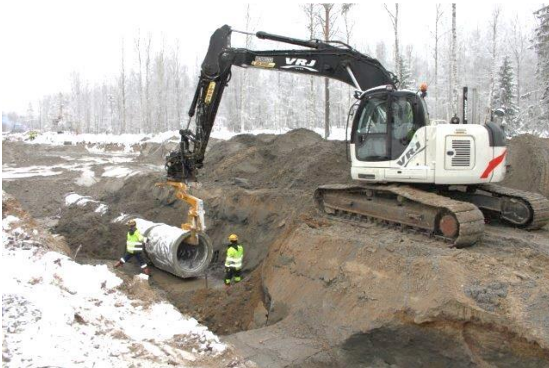
Kuva 20. Putkiasennus RB-lifterillä (J. Eloranta, henkilökohtainen tiedonanto 11.3.2014).
