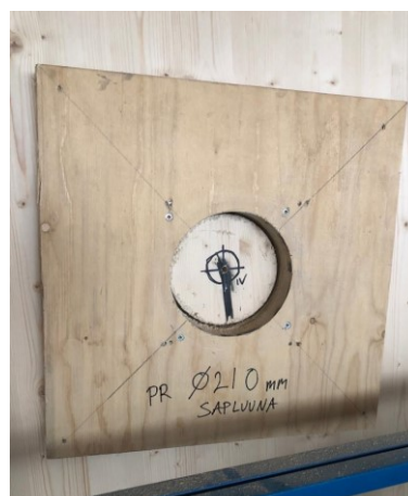
Kuva 26 (oik). Reiän tekoon käytettävä vanerinen sapluuna (Haverinen 2022).
