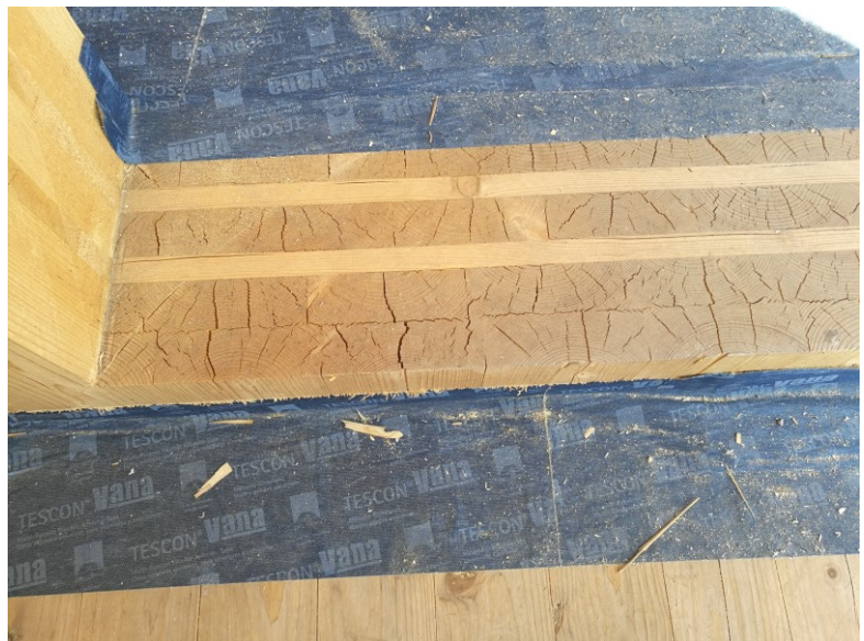
Kuva 13 (vas). Liimapuupalkkiin syntyneitä sisäisiä halkeamia (Franke ym. 2015, 3)
