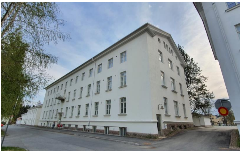
KUVA 10. Lääninsairaalan entinen talousrakennus lännestä kuvattuna (Kempainen 2023).
