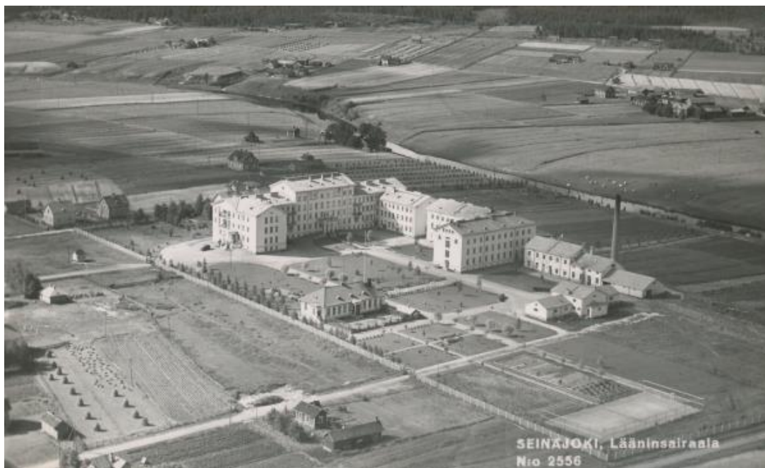
KUVA 3. Ilmakuva Vaasan lääninsairaala (Porstua-verkkopalvelu 2011).
