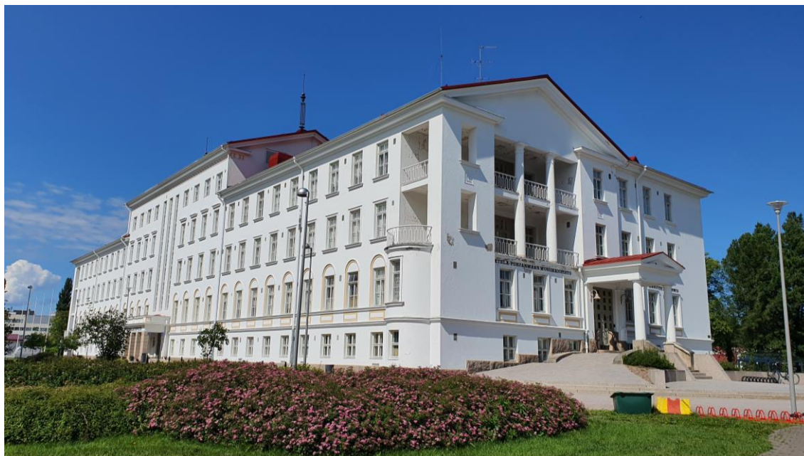
KUVA 17. Vaasan entisen lääninsairaalan päärakennuksen A-osassa toimii Etelä-Pohjanmaan musiikkiopisto. A-osa on kuvassa etualalla. (Kemppainen 2023.)
