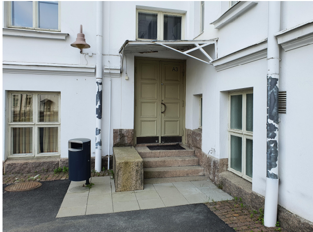
KUVA 36. Kuvassa A3 sisäänkäynti. Uusi sisäänkäynti (A4) sijoittuu kuvan oikealta laidalta laskettuna ensimmäisen ikkunan kohdalle.
