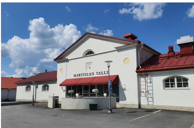
KUVA 11. Lääninsairaalan entinen talli- ja vajarakennus (Kempainen 2023).
