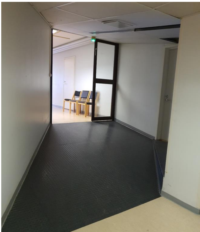
KUVA 24. Musiikkiopiston kellarikerroksen luiska (Kemppainen 2023).
