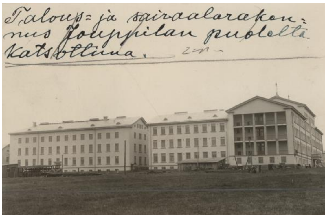
KUVA 2. Vaasan lääninsairaalan talousrakennus (vasemmalla) ja päärakennus (oikealla) lännestä kuvattuna (Porstua-verkkopalvelu 2008).
