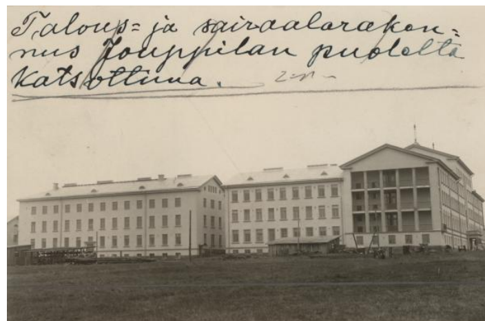
KUVA 28. Lääninsairaalan talousrakennus (vasemmalla) ja päärakennus (oikealla) lännestä kuvattuna (Porstua-verkkopalvelu n.d.).
