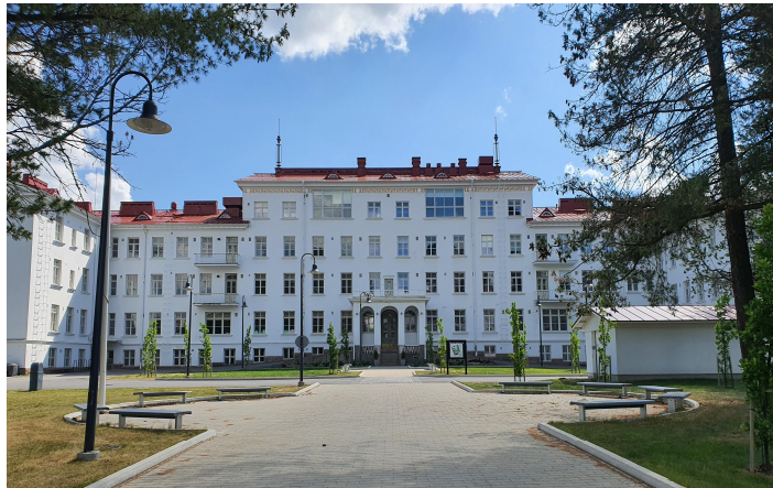
KUVA 31. Päärakennus pohjoisesta kuvattuna.
