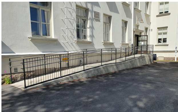
KUVA 37. Talusrakennuksen D4 sisäänkäynnin luiska.
