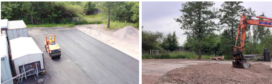
Kuva 9. Piha-alueen raivaus ja asfaltointi käynnissä, lisätilaa saatiin noin 500 neliötä. Asfaltoinnilla saatiin varastointitilaa ja kaluston liikuttelu helpottui. (Antero Myrén ja Manu Kettunen 2022.)
