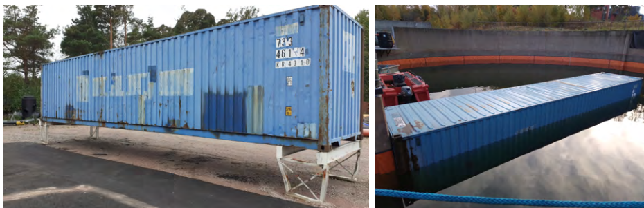
Kuva 7. Merikontti toimii laiturina ja työskentelytasona. Vasemmalla konttiin on asennettu jalakset ja oikealla kontti on laskettu altaaseen tulevaa varustelua varten. (Antero Myrén 2022.)
