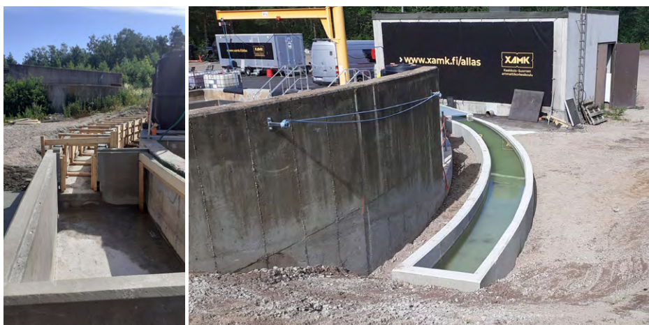
Kuva 2. Virtaavan veden ojan betonivalu 1.7.2022 ja oja tiiveyskokeessa (Antero Myrén 2022).
