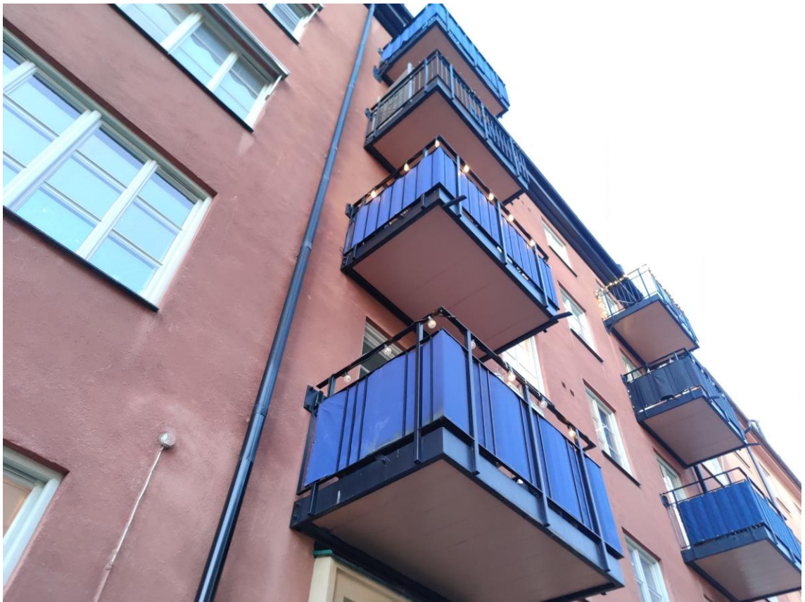
KUVA 17. Tukholmassa osoitteessa Bergsundsgatan 13 toteutettuja teräsrunkoisia parvekkeita (Valkeamäki 2022).
