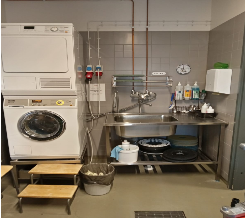
KUVA 8. Tahto Areenan siivouskeskus (Kuva: Laitoshuoltaja 2023)
