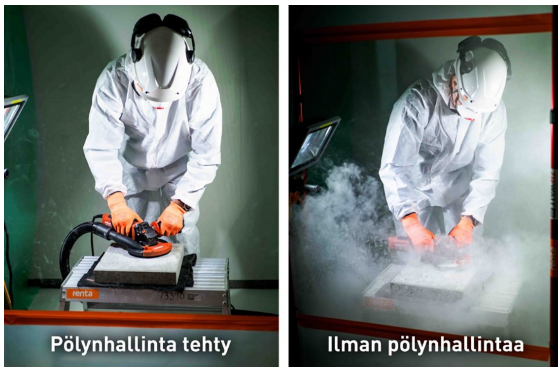
Kuva 2. Betonipinnan hiominen pölynhallinnan kanssa ja ilman pölynhallintaa [25].
