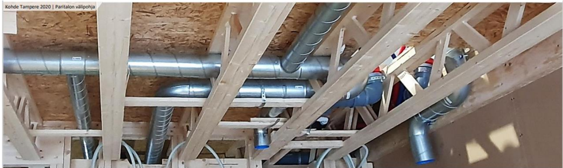
KUVA 1. Ilmanvaihtoputkien vedot paritalon välipohjassa (TK-PALKKI, 3)
