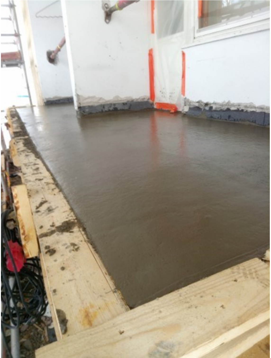
Kuva 3. Uusi parvekelaatta valettuna
