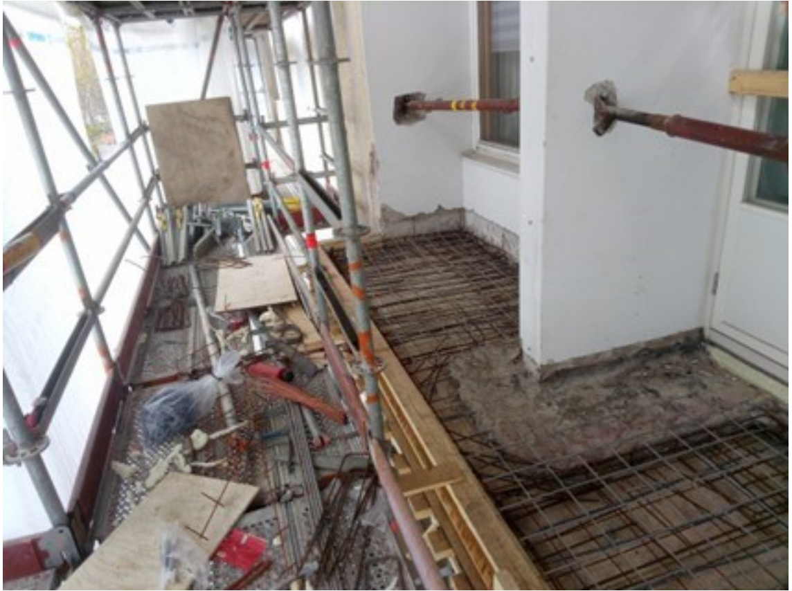
Kuva 2. Uuden parvekelaatan muotti- ja raudoitustyö
