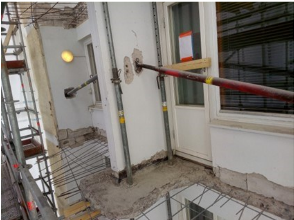
Kuva 1. Parvekkeen väliaikaiset tuennat
