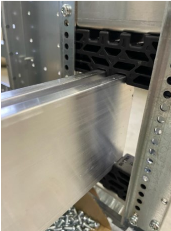
Kuva 40. Vaakakokoojakiskot ja VMS3-10 tukieristimet asennettuna.
