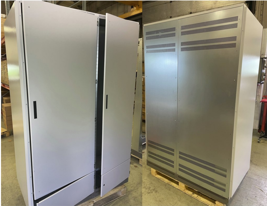
Kuva 45. Ovet ja takalevyt asennettuna.
