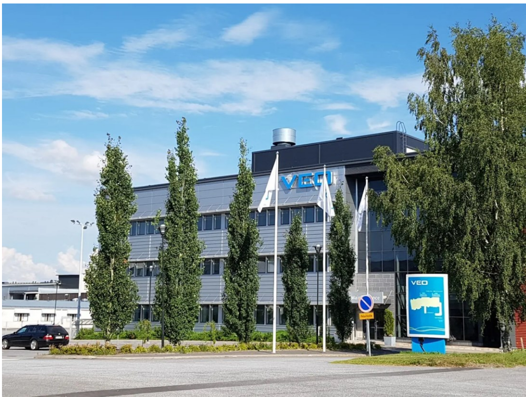
Kuva 1. VEO Oy pääkonttori ja kojeistotehdas
