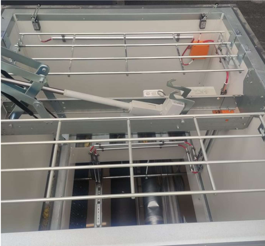
KUVA 2. Savunpoistoluukun kytkennät
