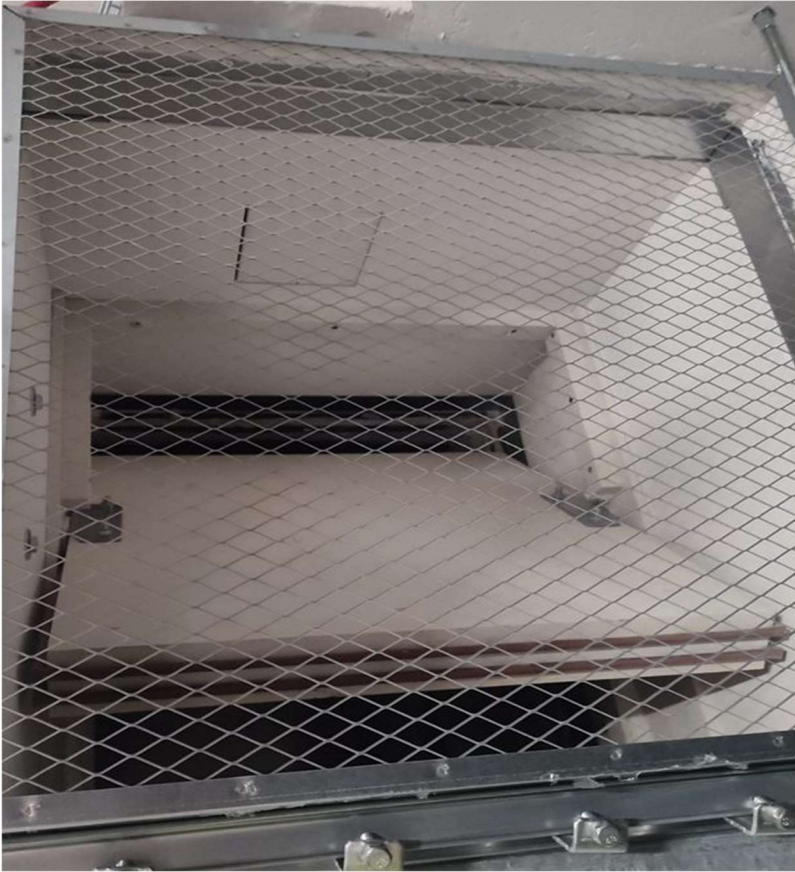
KUVA 29. Savunpoistopelti edestä osittain auki
