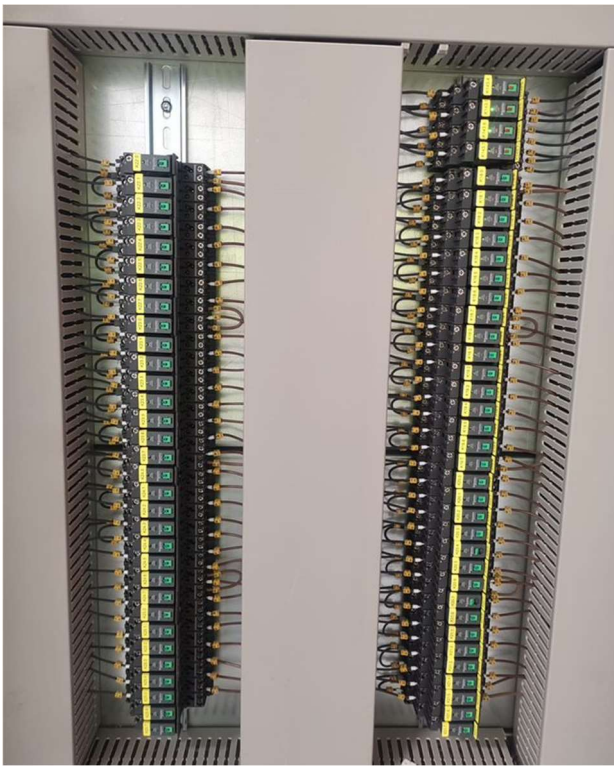
KUVA 10. Savunpoiston ohjausreleet
