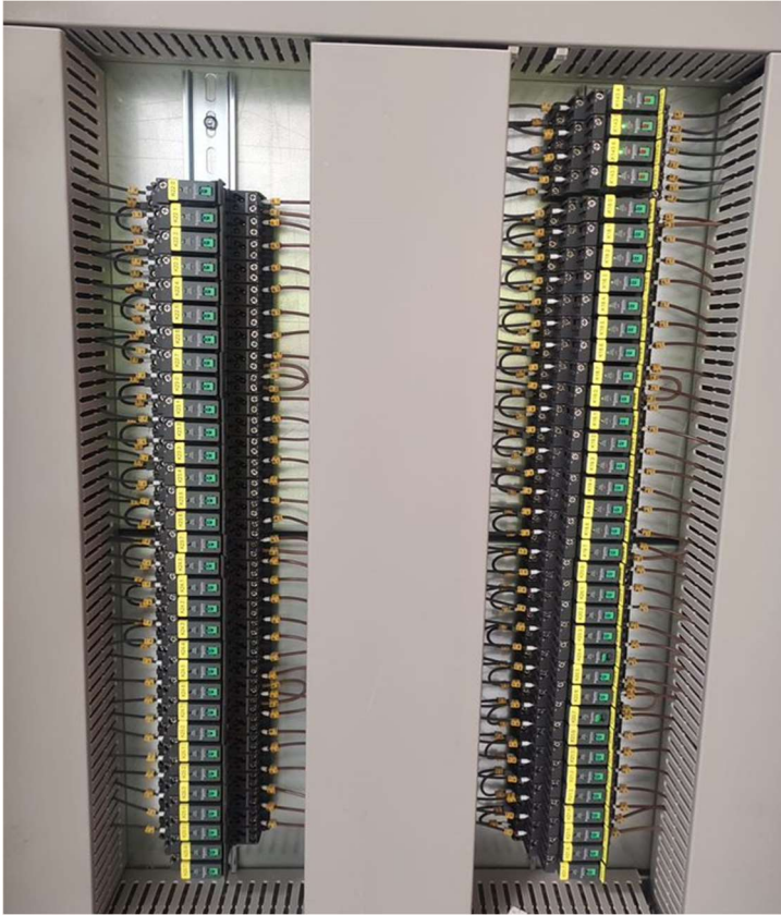
KUVA 16. Savunpoiston ohjausreleet.
