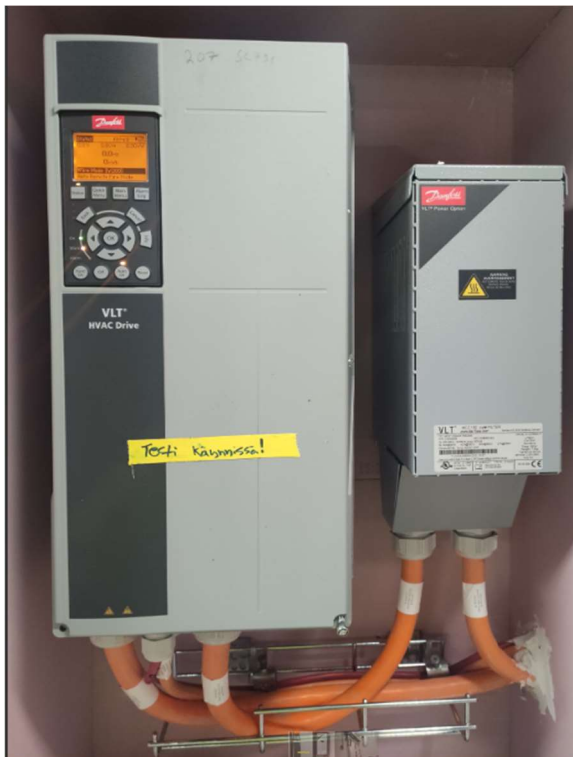
KUVA 27. Taajuusmuuttaja ja suodin
