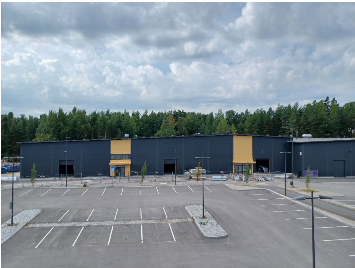
Kuva 2. Rakennusaikana otettu kuva heinäkuussa 2022.
