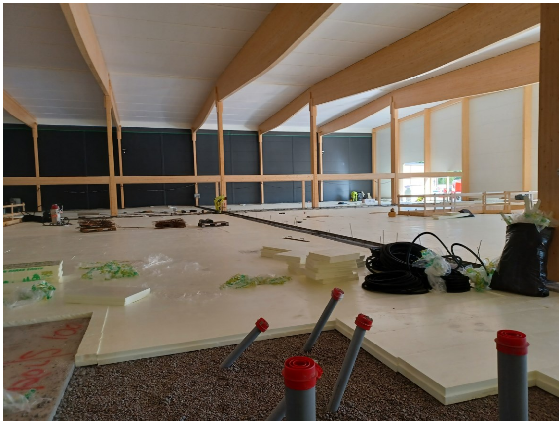
Kuva 4. Ennen lattiavalua otettu kuva.
