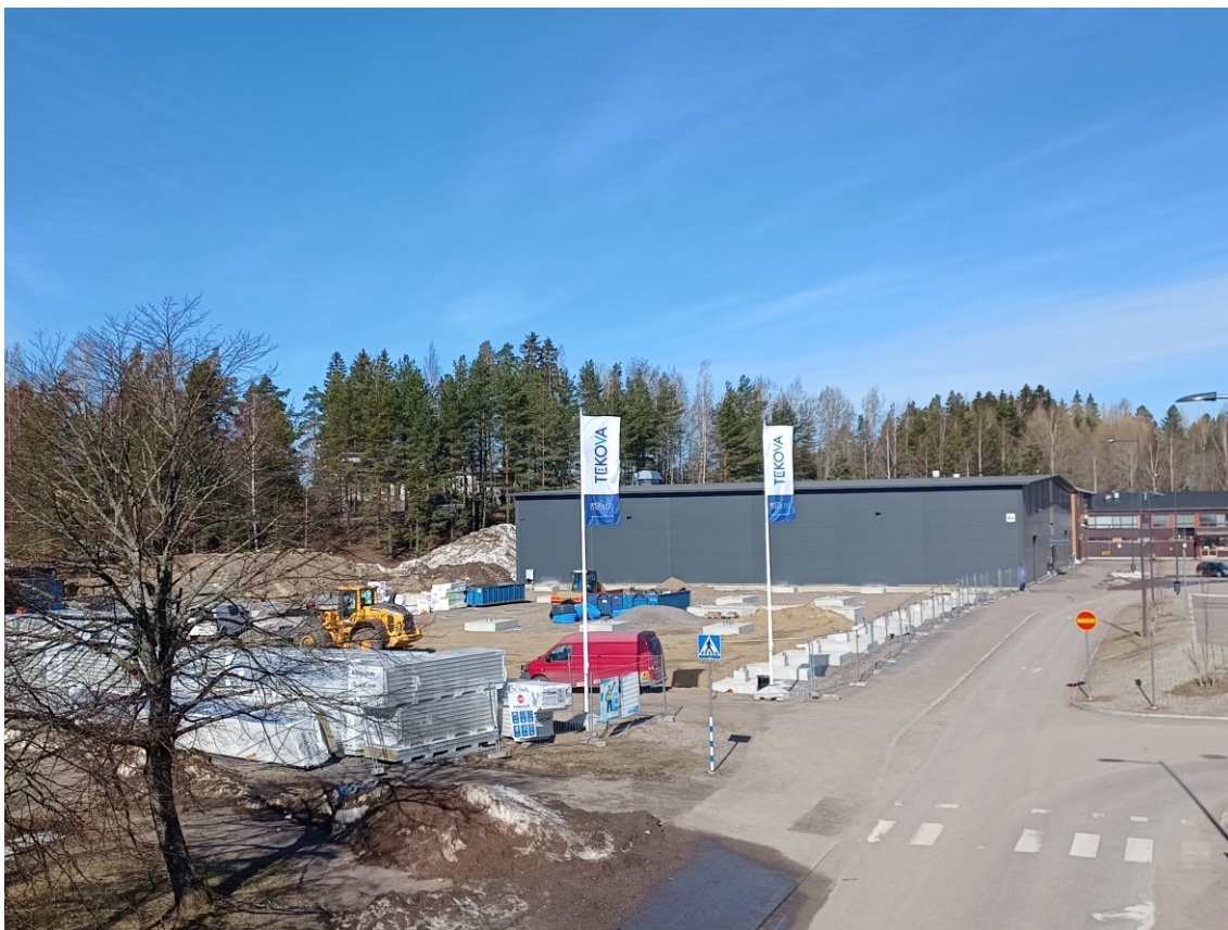
Kuva 7. Kuva työmaasta perustusvaiheessa.
