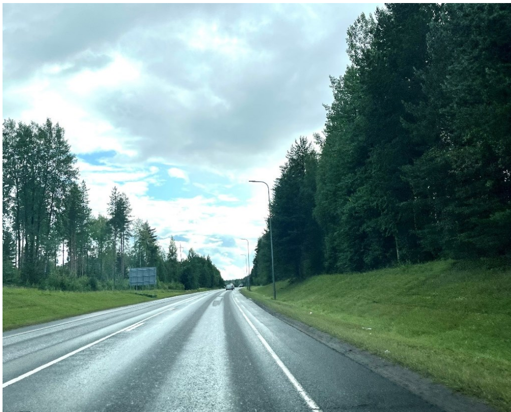
KUVA 4. N2-hoitoluokkaa 5-tiellä Kajaanissa (Tolonen 2023)
