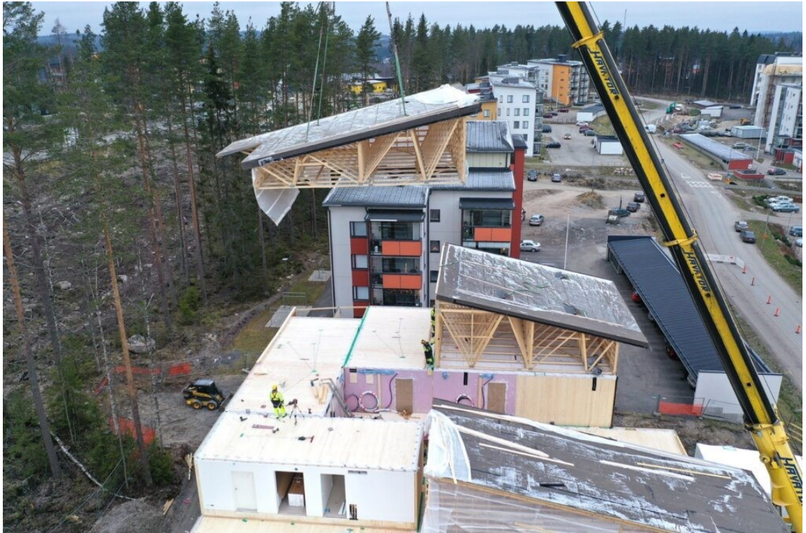
Kuva 6. Suojakatto rakennuksen lopullisista kattolohkoista (Puuinfo 2022)
