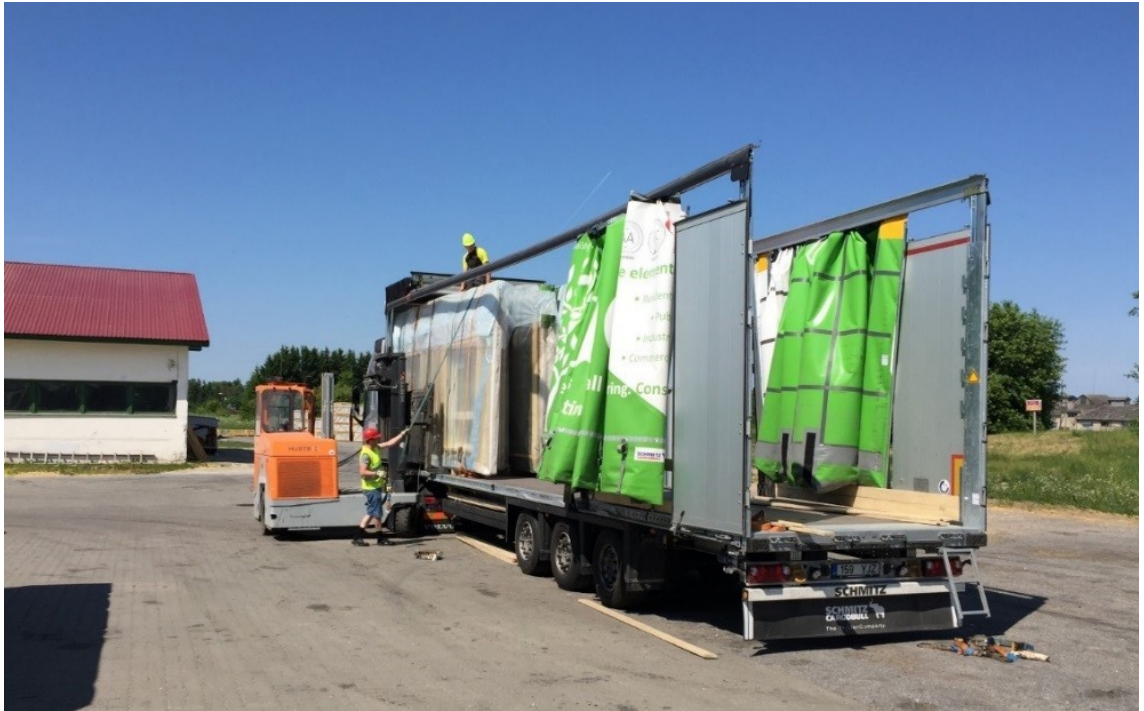
Kuva 2. Suurelementtikuljetus työmaalle suojapeitteisellä rekalla (Puuinfo 2022)
