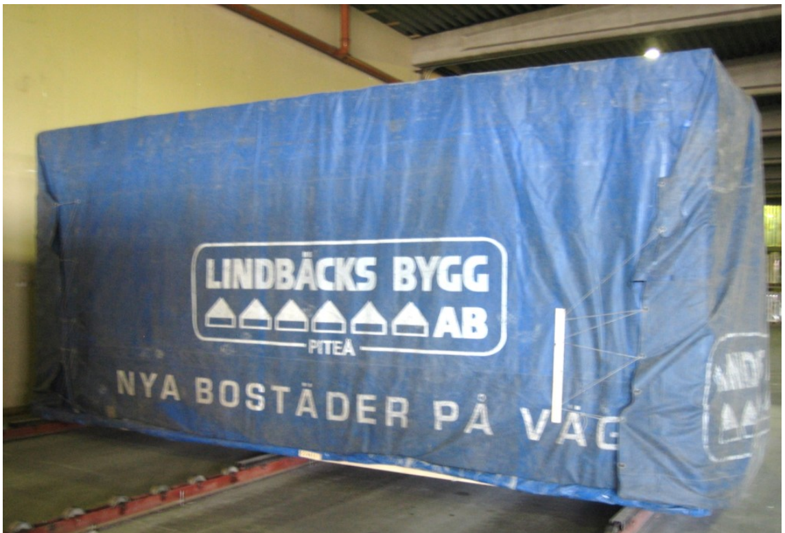
Kuva 3. Tilaelementin suojaus uudelleen käytettävällä pressulla (Puuinfo 2022)
