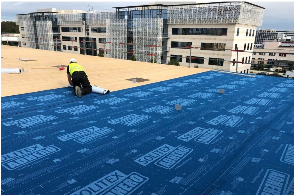
Kuva 8. Mikrokuitukankaan asennus CLT-välipohjan päälle (Puuinfo 2022)
