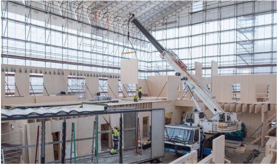
Kuva 5. CLT-elementin asennus nosturiautolla suojateltassa (Puuinfo 2022)
