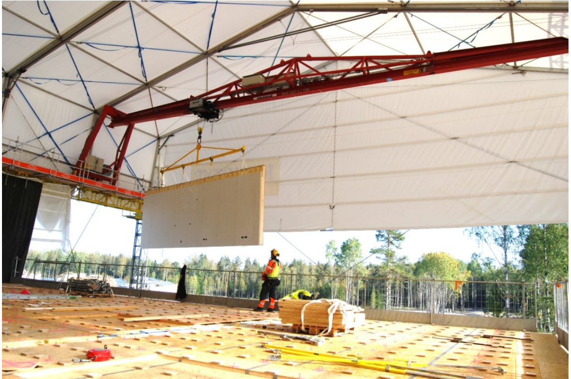
Kuva 4. Tilaelementin asennus siltanosturilla suojateltassa (Puuinfo 2022)
