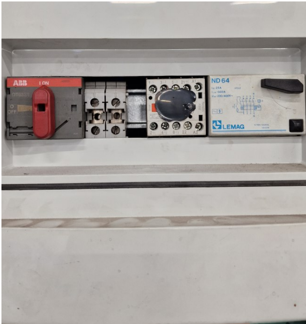
KUVA 2 Kontaktorin kosketukselle alttiit jännitteiset ruuvit
